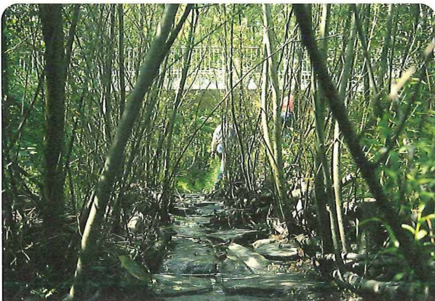
Bild 3.4.2.11: Der Flechtzaun (aus Bild 3.4.2.8) nach 3 Jahren
