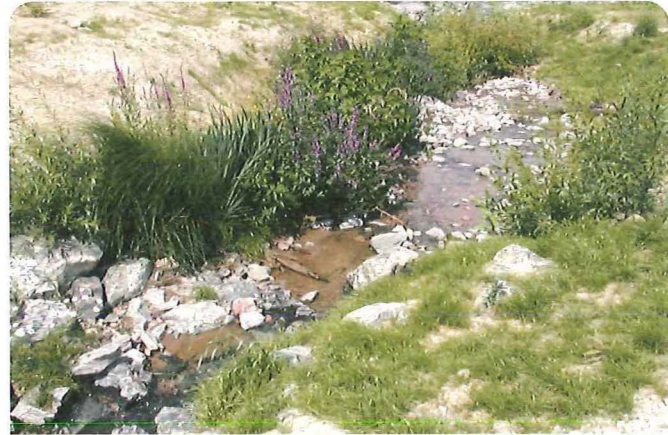
Bild 3.3.2: Vegetationswalze mit anschließender Hochstaudenpflanzung nach 4 Monaten
