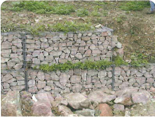
Bild 3.4.3.17: Begrünte Gabione – Austrieb der Buschlagen, 4 Wochen nach dem Einbau
