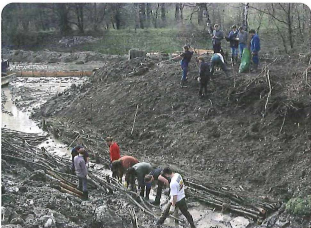
Bild 3.4.2.8: Bau eines Flechtzaunes
