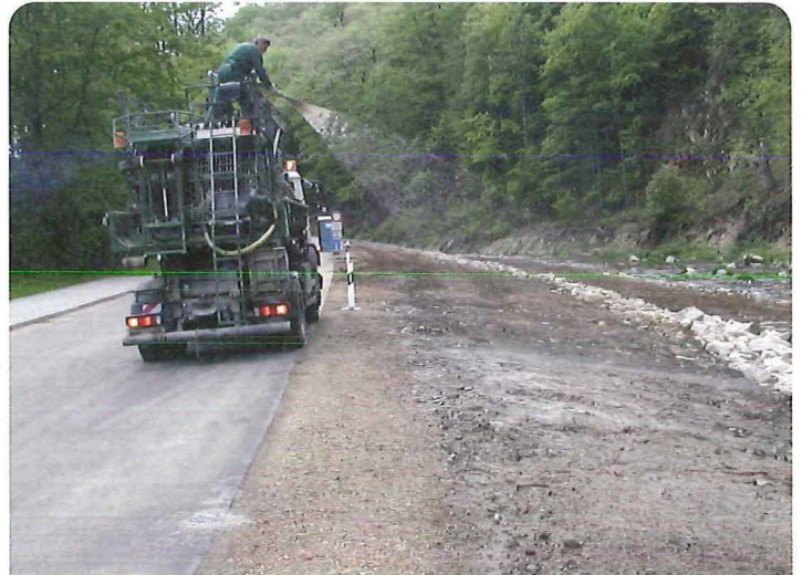
Bild 3.2.2: Nassansaat in der Ausführung
