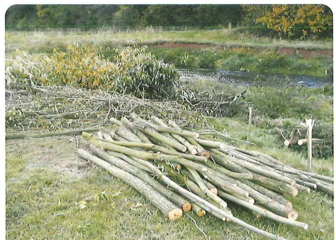
Bild 2.6.3.2: Die Aufbereitung des benötigten Baumaterials für ingenieurbioologische Bauweisen erfolgt möglichst direkt am Einbauort
