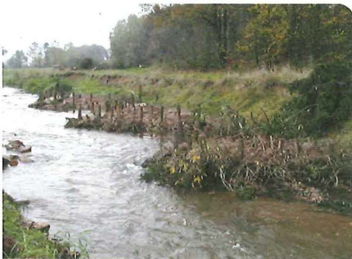
Bild 3.4.3.7: Fertiggestellte Buhne mit Buschbautraverse, sofort wirksamer Uferschutz und Strömungsberuhigung in den Buhnenfeldern
