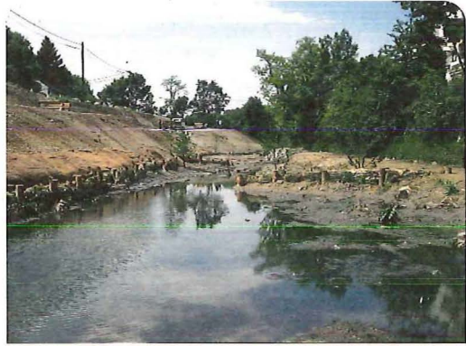
Bild 2.3.4: Neben der Sicherung der Uferböschungen werden ingenieurbio-logische Bauweisen zunehmend auch zur Gewässerstrukturierung bei Nieder- und Mittelwasser eingesetzt
