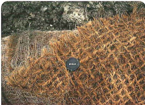
Bild 3.4.3.2: 2-lagige Böschungsschutzmatten zur Verhinderung von Ausspülungen unterhalb der Matte
