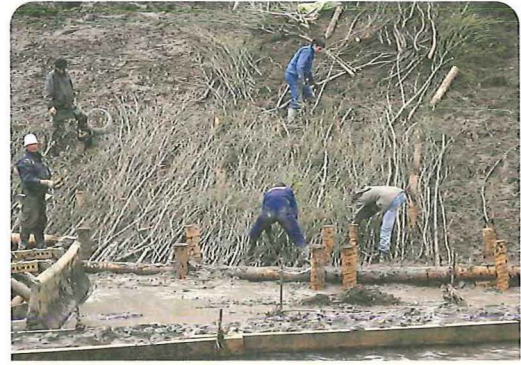
Bild 3.4.2.16: Spreitlagenbau – lebende Weidenäste werden vollflächig und dicht aufgelegt
