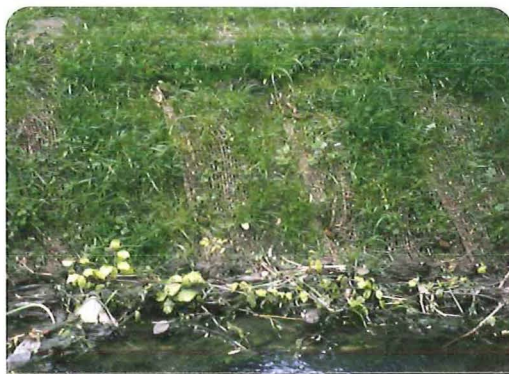
Bild 3.2.6: Mit Rasensoden befestigte Uferböschung, kombiniert mit Totfaschine als Böschungfußsicherung; bereits zwei Wochen nach dem Einbau beginnen die Rasensoden die Matte zu durchwachsen und bilden einen wirksamen Uferschutz
