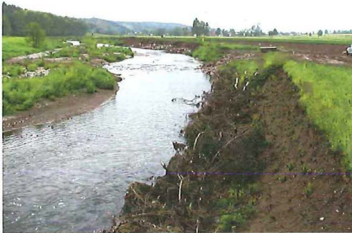
Bild 2.4.1: Raubbäume sichern den Böschungsfuß linear; der daran anschließende Steckholzverbund wirkt in der Initialphase noch punktuell, später als flächige Böschungssicherung
