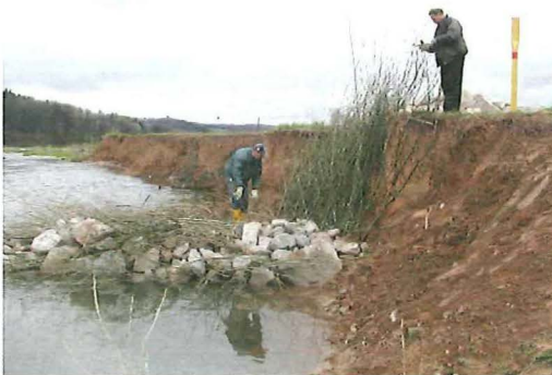
Bild 3.4.3.11: Buschbauleitwerk zum Bau einer Buhne
