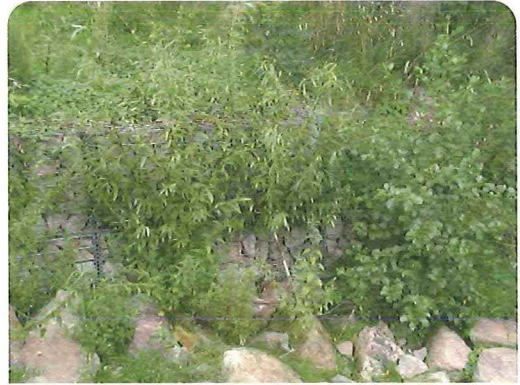
Bild 3.4.3.18: Begrünte Gabione nach zwei Jahren
