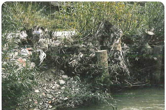
Bild 3.4.2.7: Wurzelstöcke verursachen bei Überflutung große Turbulenzen, wodurch sie ausgespült werden können
