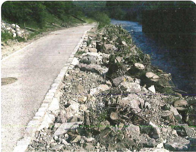
Bild 3.4.2.6: Einbau von Wurzelstöcken zur Böschungssicherung
