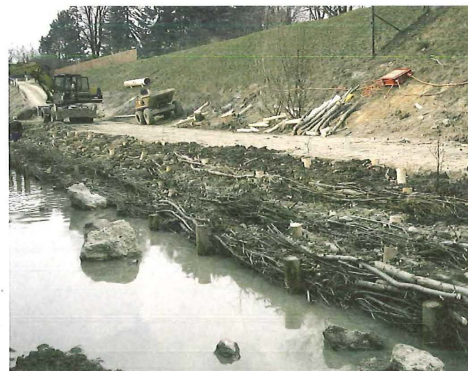
Bild 3.4.2.13 : Reihen aus Faschinen zur flächigen Böschungssicherung
