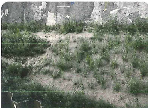
Bild 3.4.3.3: Begrünung und Befestigung einer Böschungsschutzmatte aus Kokosgewebe mit Steckhölzern
