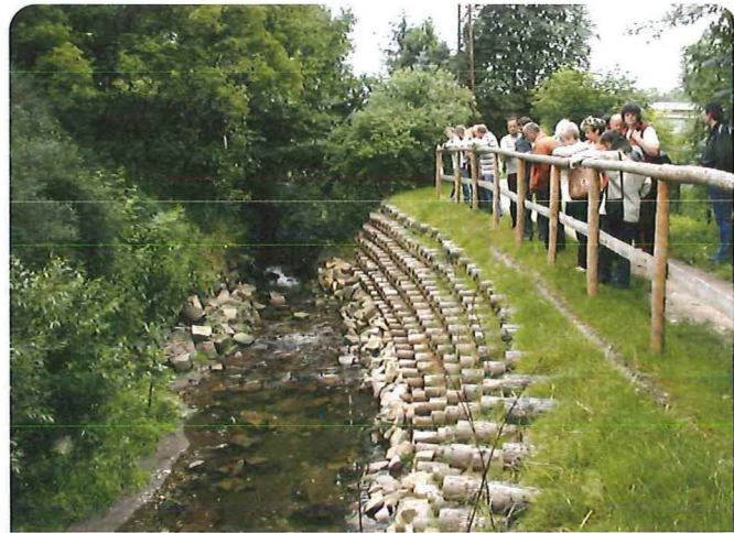
Bild 3.4.3.9: Fertiggestellte Holzkrainerwand zur Sicherung der Uferböschung bei parallel zum Gewässer verlaufendem Weg
