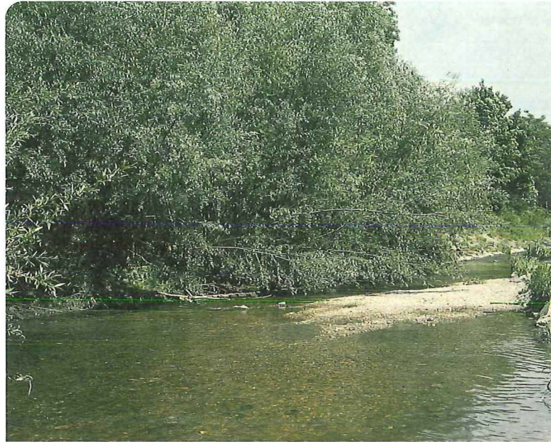
Bild 3.4.2.18: Die Spreitlage (aus Bild 3.4.2.17) nach 3 Jahren, sie sichert das Ufer und wertet das Gewässer ökologisch auf
