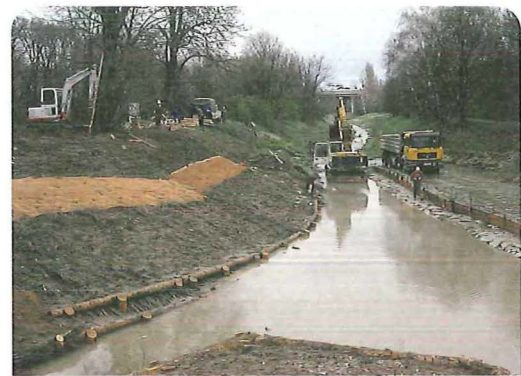
Bild 3.4.2.17: Spreitlage nach Fertigstellung – die Fußsicherung erfolgt mittels Holzkonstruktion und oberhalb der Spreitlage ist eine Böschungsschutzmatte angebracht
