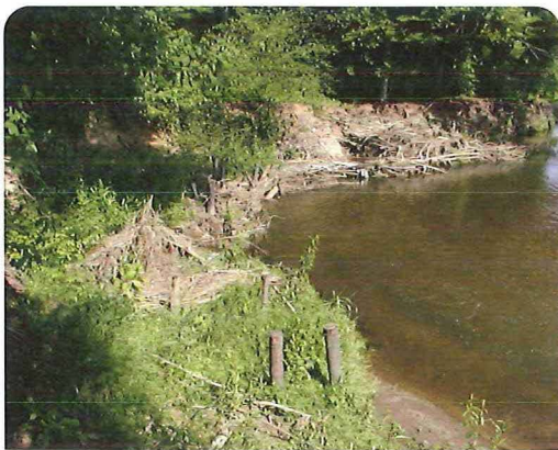
Bild 3.4.3.6: Im Schutz der Raubäume entwickelt sich ein neues Ufer, dass durch Naturverjüngung aus Erlen und Weiden dauerhaft gesichert ist
