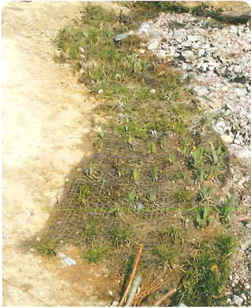
Bild 3.3.1: Vegetationswalze mit anschließender Hochstaudenpflanzung
