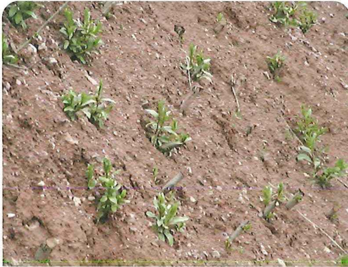
Bild 3.4.2.1: Steckholzverbund – Austrieb der Weiden kurz nach dem Einbau
