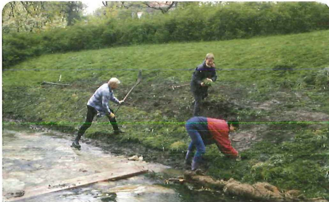
Bild 3.2.5: Auslegen und Einbauen der Rasensoden erfolgt in Handarbeit
