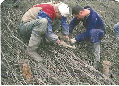
Bild 3.4.2.15: Spreitlagenbau – Befestigung der Weidenäste mit Bindedraht
