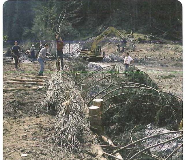
Bild 3.4.2.12: Einbau von Faschinen hinter einer Fußsicherung aus Raubäumen
