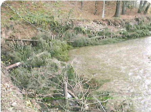
Bild 3.4.3.5: Sicherung des Prallufers durch Einbau von Raubäumen
