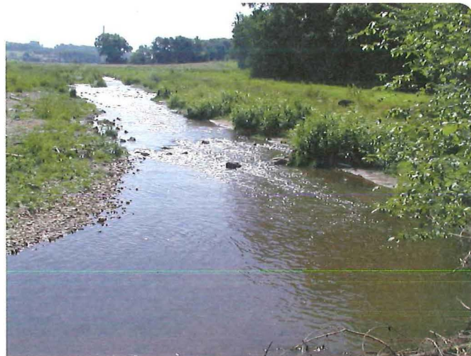
Bild 3.4.3.8: Drei Monate nach Beginn der Vegetationsperiode haben sich die Weiden der Buschbautraverse sehr gut entwickelt, auf den Anlandungen in den Buhnenfeldern führt Sukzession zur zunehmenden Verfestigung der neuen Uferlinie
