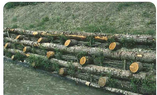
Bild 3.4.3.10: Sicherung der Zwischenräume zwischen den Längshölzern durch Faschinen
