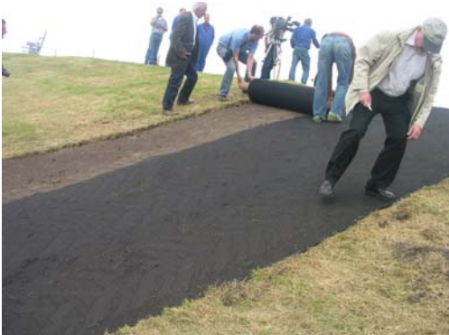
Figuur 6-3: Plaatsen van het geokunststof
