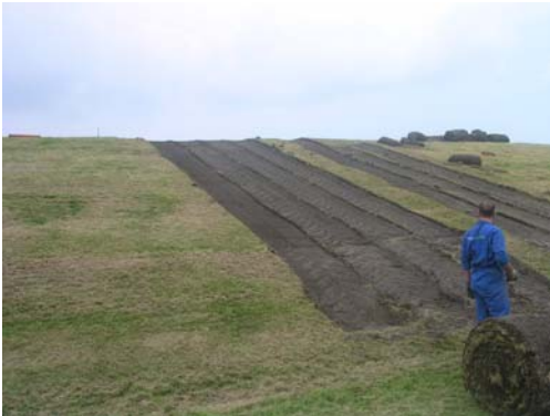
Figuur 6-2: Dijk na het oprollen van de graszode
