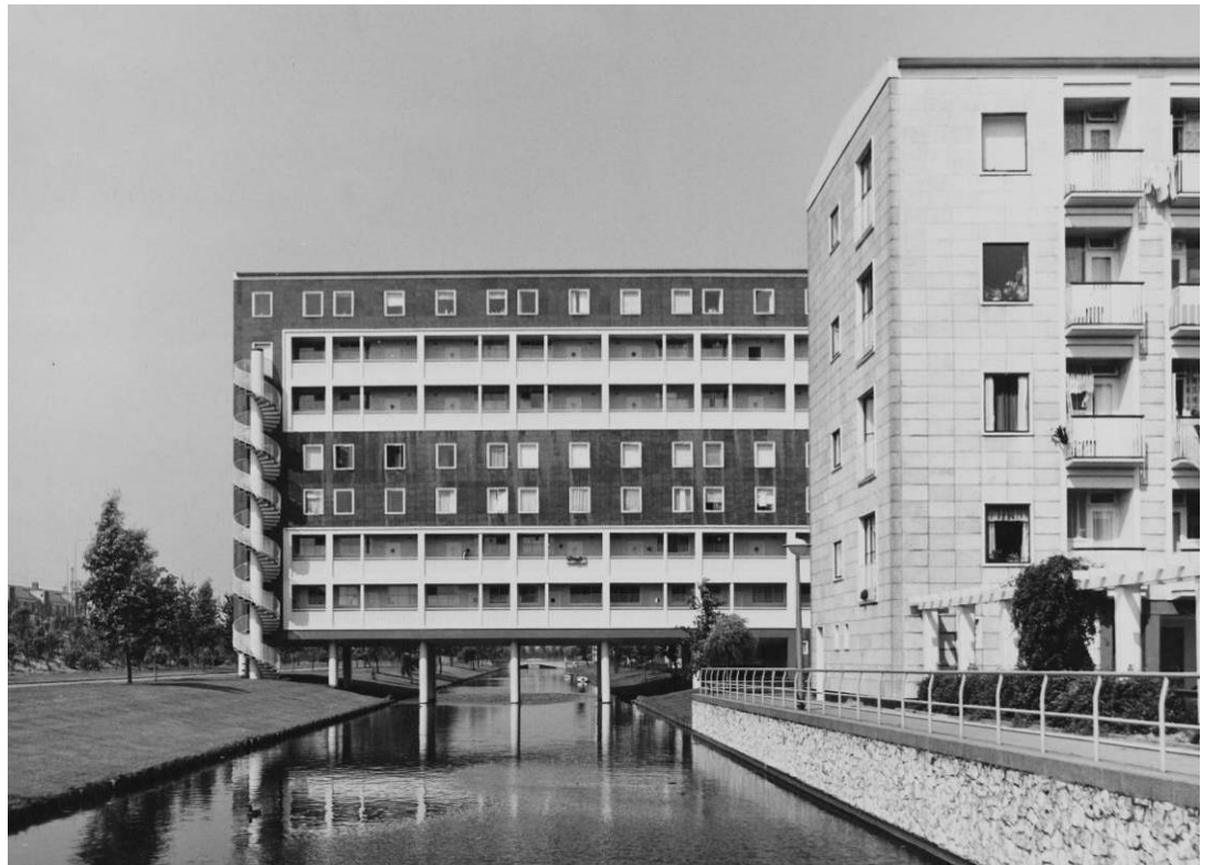
Fig. 2.12. De overkraging van de hoge blokken over het water, het wandelpad en de pergola's (BERX NAi).
