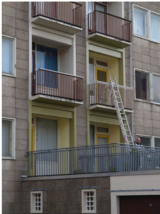
Fig. 2.82. Werk in uitvoering in 2009: onderhoud aan het dak en schilderwerk.
