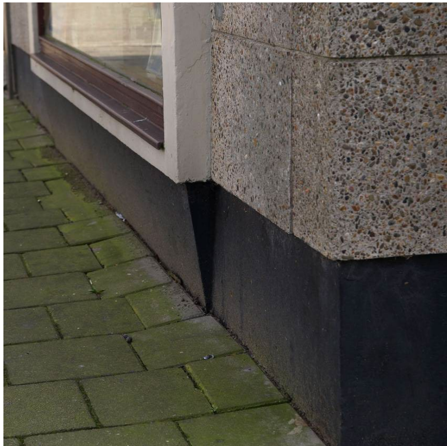
Fig. 2.96. Krachtig in eenvoud: afschuining van de betonnen plint.
