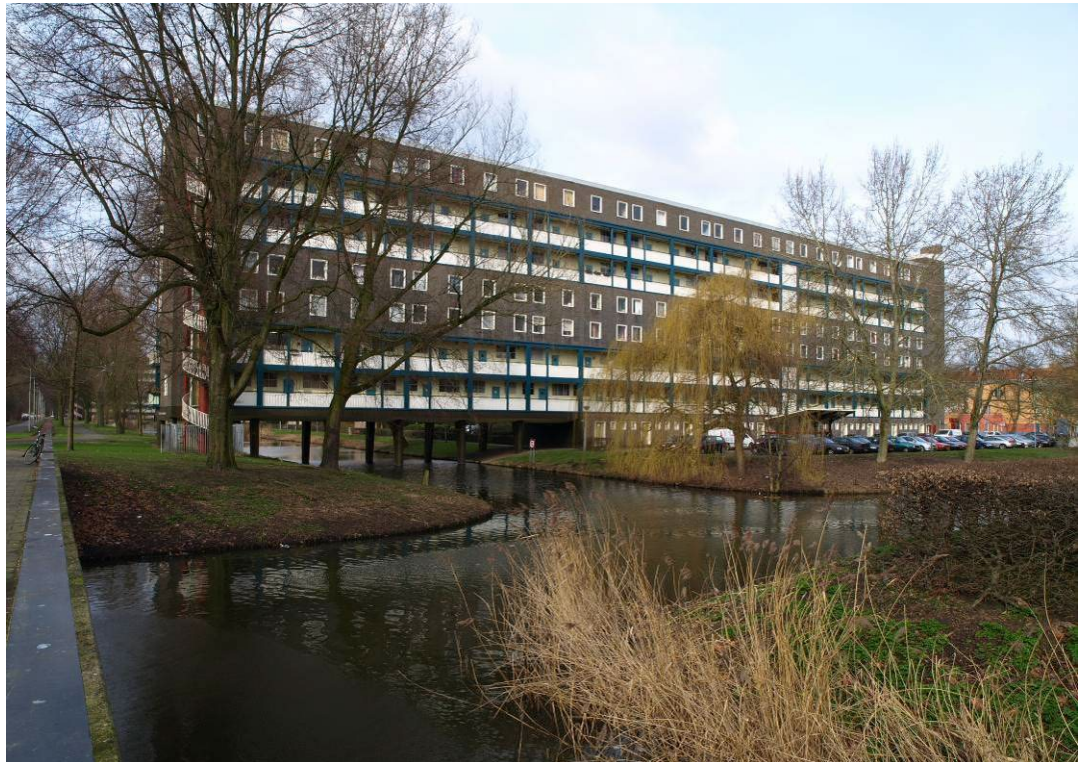
Fig. 2.134. Object: één van de hoge schijven met de markante lichte galerijstroken, met spiltrap, schoorsteen en haar voeten in het water bepalend in positie en herkenning.
