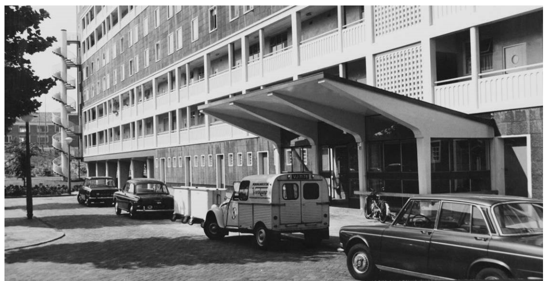
Fig. 2.16. De entree van een hoog schijf (M) aan de binnenhof (BERX NAI).
