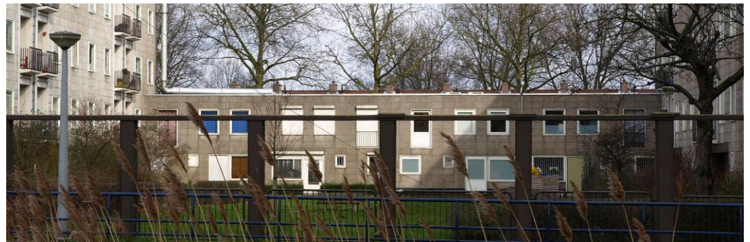
Fig. 2.65. De zuidgevel van de winkel/woningen met pergola in maart 2009.
