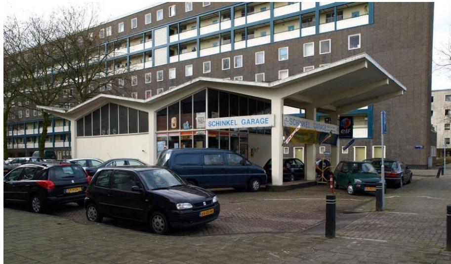
Fig. 2.88. De beide service-stations zijn nog steeds als zodanig in gebruik.
