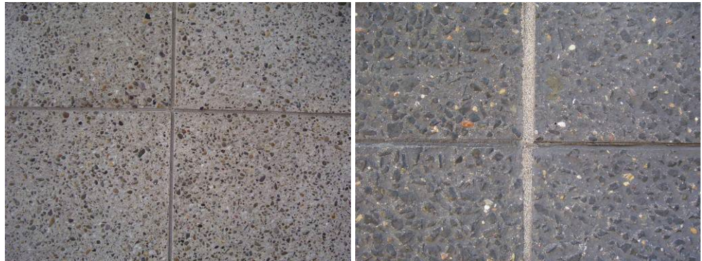
Fig. 5.2. Voorbeeld van verschillend toeslaggebruik in de beton panelen van de blokken vijf hoog (B) en toren (T): goed afgerond donker bruinig grind versus hoekig gebroken materiaal in een (gekleurd ?) vlak. Merk bij de toren ook het verschil tussen de oorspronkelijke en reparatievoeg op.
