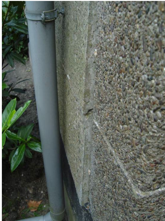
Fig. 4.7. Wijken kopgevel uit het gevelvlak.
