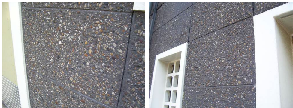
Fig. 5.4. De donker gekleurde beton platen van de blokken zeven hoog (M). Bij beschouwing in detail blijkt dat zij allen een duidelijke horizontale tekening hebben, waarschijnlijk omdat ze tijdens de verharding gebezemd zijn.
