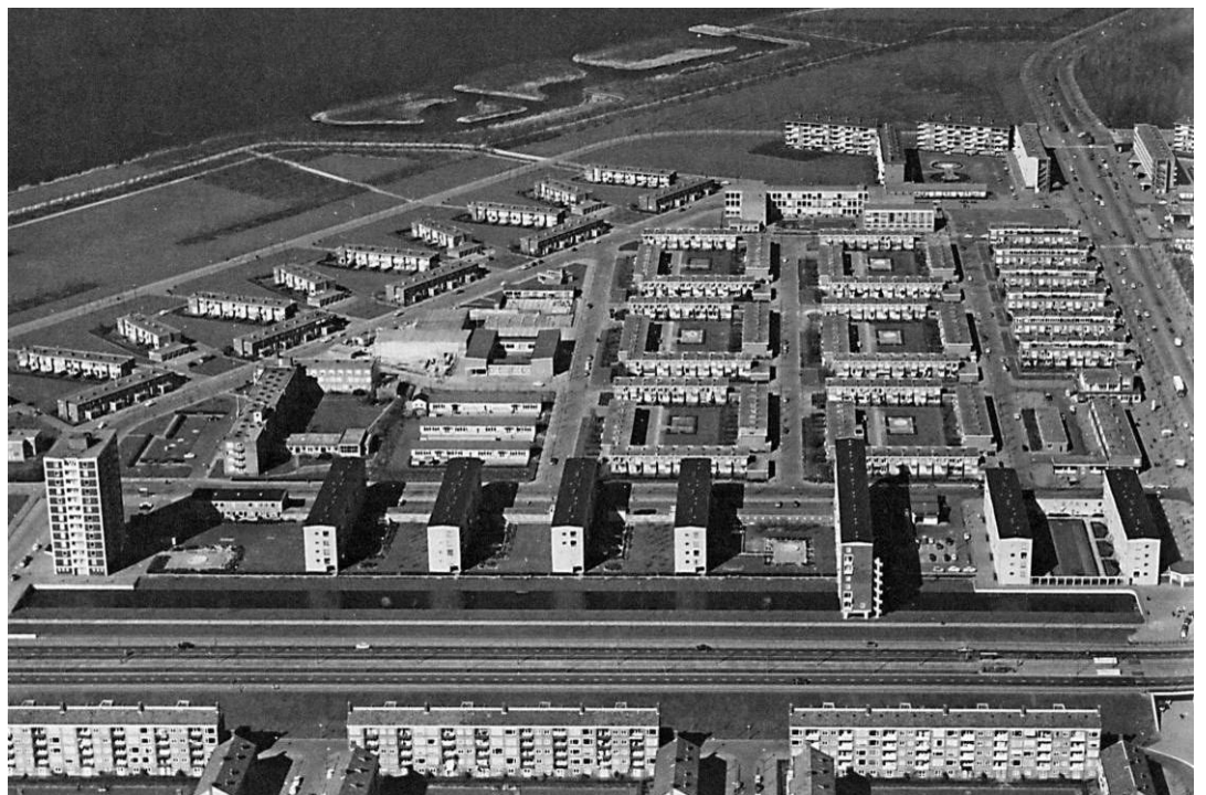
Fig. 2.10. Het westelijke deel van Slotershof met de Torenflat en de atelierwoningen links, nabij de Hemsterhuisstraat (Messcheart 2004).
