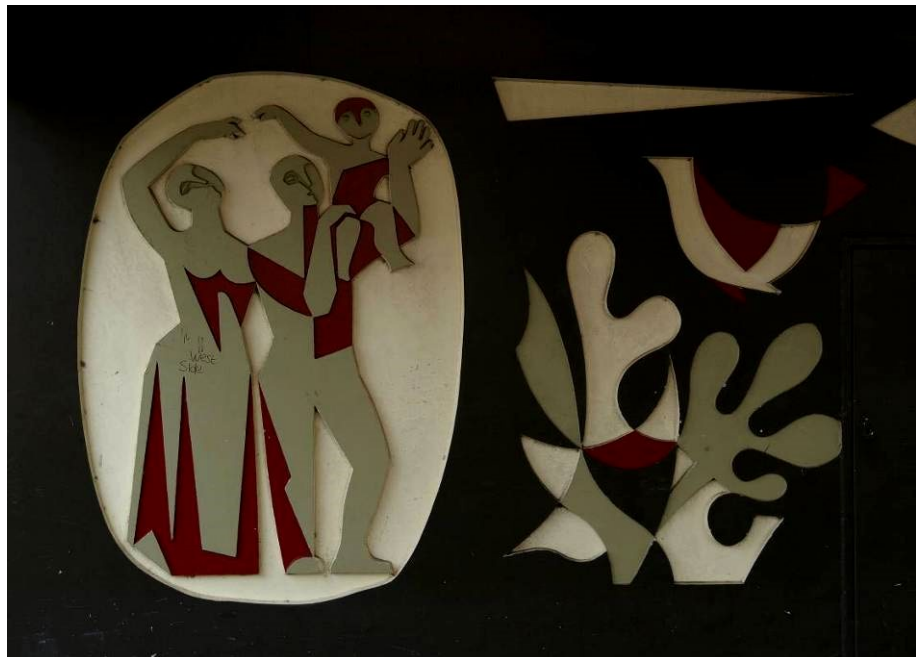
Fig. 2.137. Detail: bij alle gemeenschappelijke entrees zijn kunstwerken in betonrelief toegepast die de model staan voor een opgewekte samenleving.
