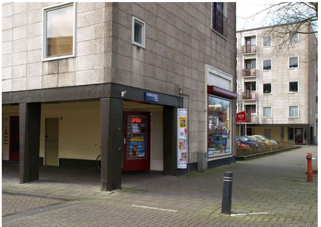
Fig. 2.135. Object: de winkels op de koppen van de lage blokken functioneren nog steeds en zijn bepalend voor een levendig straatbeeld en het functioneren van de openbare ruimte.
