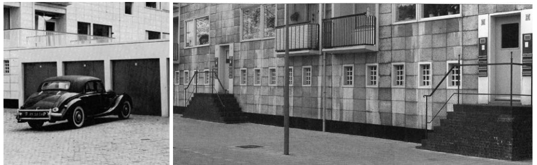
Fig. 2.14. Links: De garages voor particulier gebruik (Fischer 1968). Rechts: De entrees voor de woningen aan de Johan Huizingalaan (Fischer 1968).
