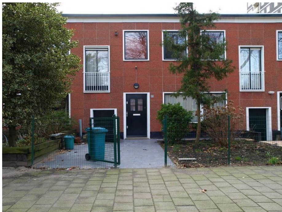
Fig. 2.93. De lagere blokken en de atelierwoningen in hun eenvoudige schoonheid.
