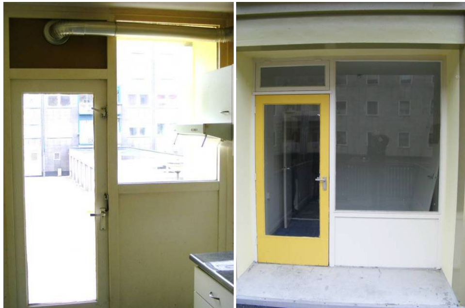
Fig. 3.1. De terugliggende gevels bij de balkons met de houten kozijnen.
