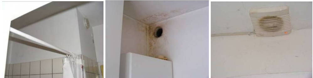
Fig. 3.6. Voorbeelden ventilatie afvoervoorzieningen.
