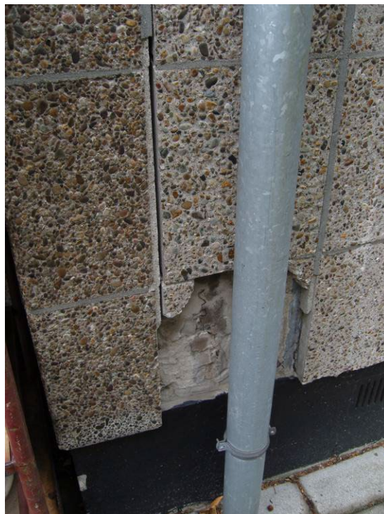
Fig. 4.14. De ruimte achter het betonplaatje is aan de voet van de gevel gevuld met beton.
