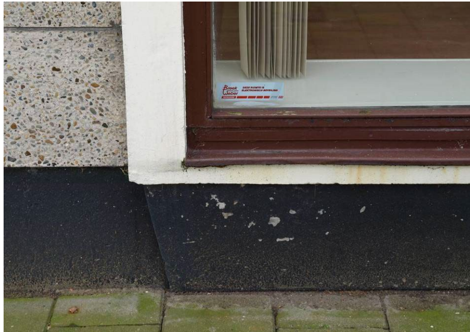
Fig. 2.136. Detail: het gewassen beton van de gevelelementen, het gladde witte betonnen kozijnkader met het dun gedetailleerde stalen kozijn, die worden verbonden door de terugliggende plint.
