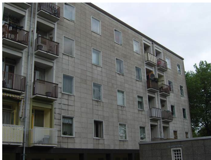
Fig. 4.1. Overzicht van een deel van één van de achtergevels. De geprefabriceerde beton panelen zijn in goede staat.
