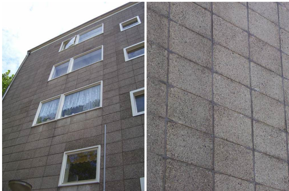
Fig. 5.5. Oorspronkelijk (links) en met kitvoegen gerepareerd (rechts) voegbeeld van blokken vijf hoog (B).
