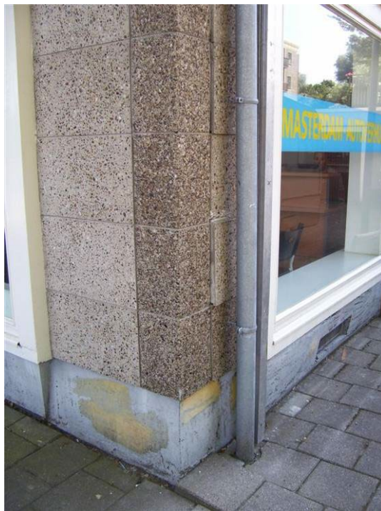
Fig. 4.10. Verplaatsing verschillende beton panelen.
