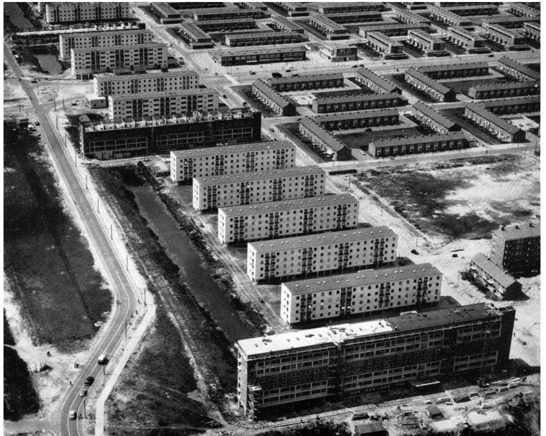
Fig. 2.9. Het oostelijke deel van Slotershof in aanbouw (Fischer 1968).
