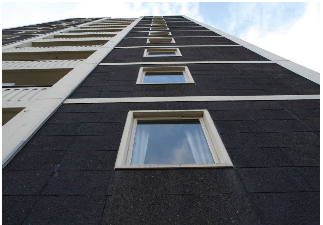
Fig. 2.111. Blok T (Toren) de gevel in 2009.
