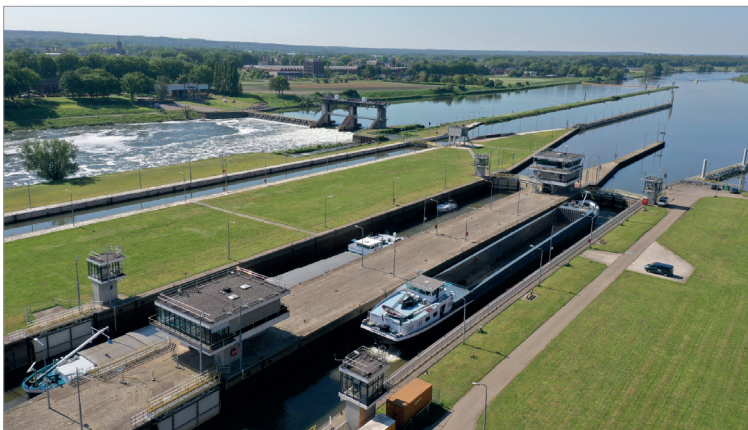
Figure 3: Ship lock Sambeek (Rijkswaterstaat)
