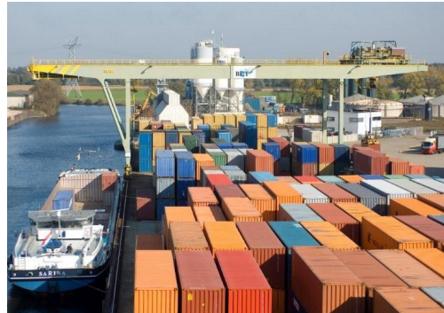
Figuur 9-1 Parallele kade met brugkraan [J]
