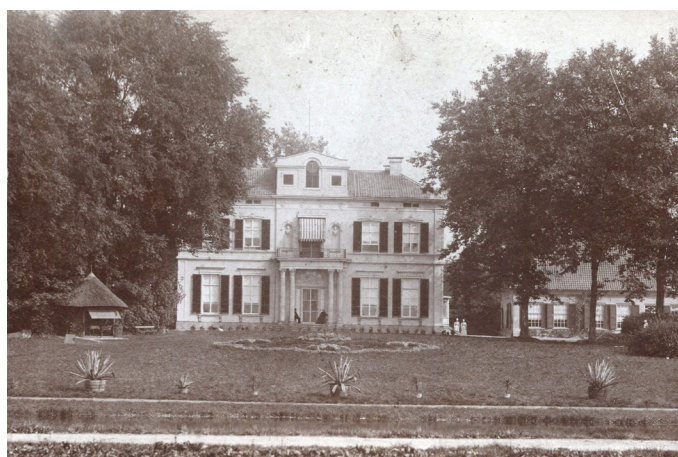
Fig 1. Case study House Reuversweerd (Erfgoedcentrum Zutphen, n.d.).
