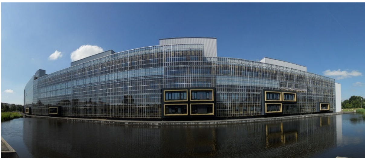
FIGURE 3.4 - THE EAST WING OF THE MARTINI ZIEKENHUIS IN GRONINGEN. IMAGE: WIKIMEDIA COMMONS
