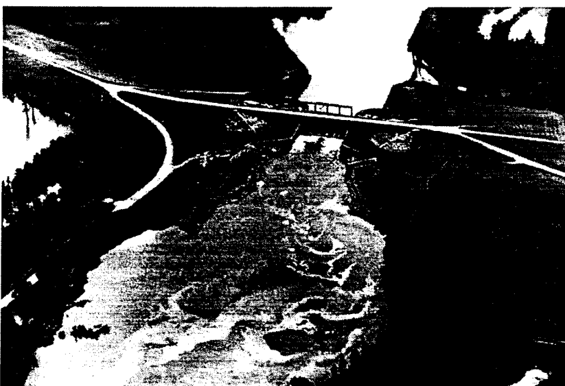
Gevolgen van een ondeugdelijke oeverbescherming
