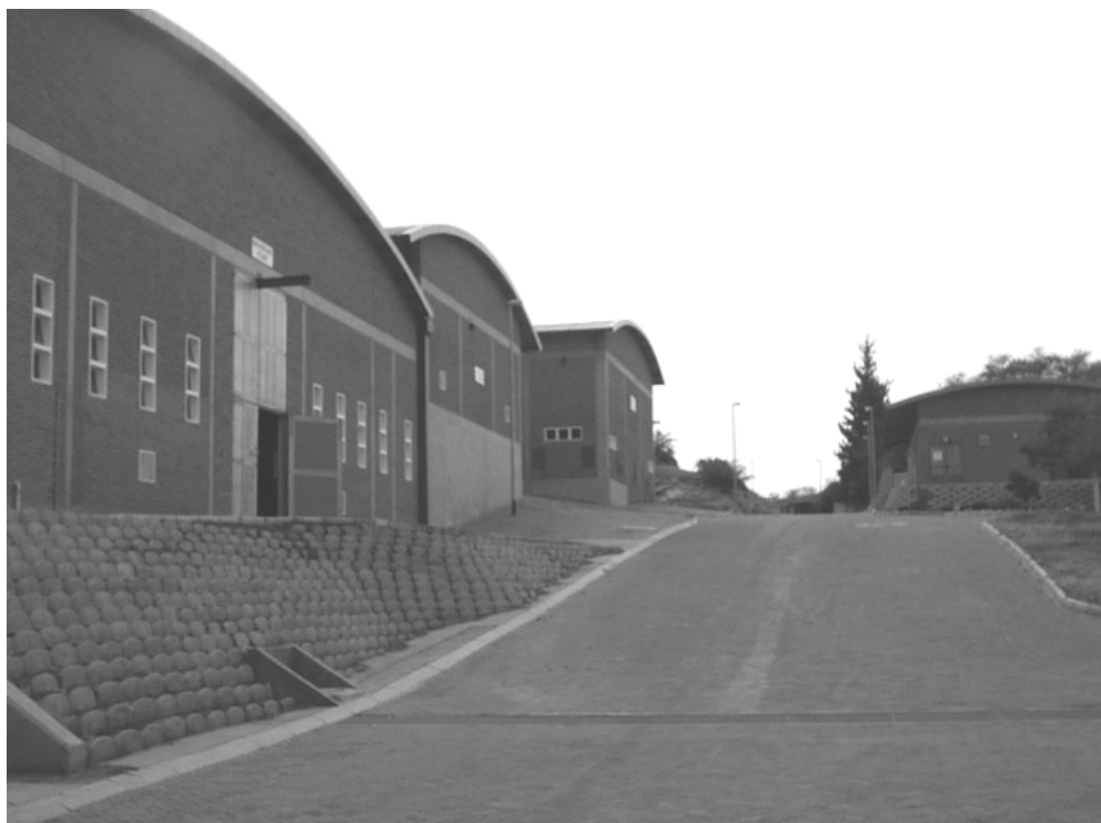
Afbeelding 4.2: New Goreangab Water Reclama- tion Plant.
