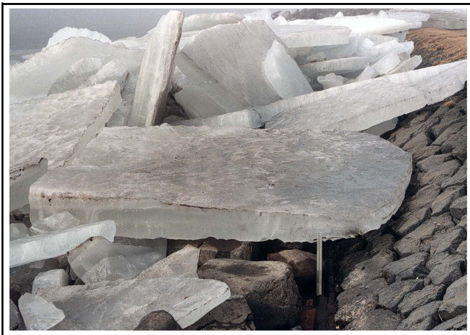
Figuur 6.3 Kruien van ijs door overgang van berm naar talud
