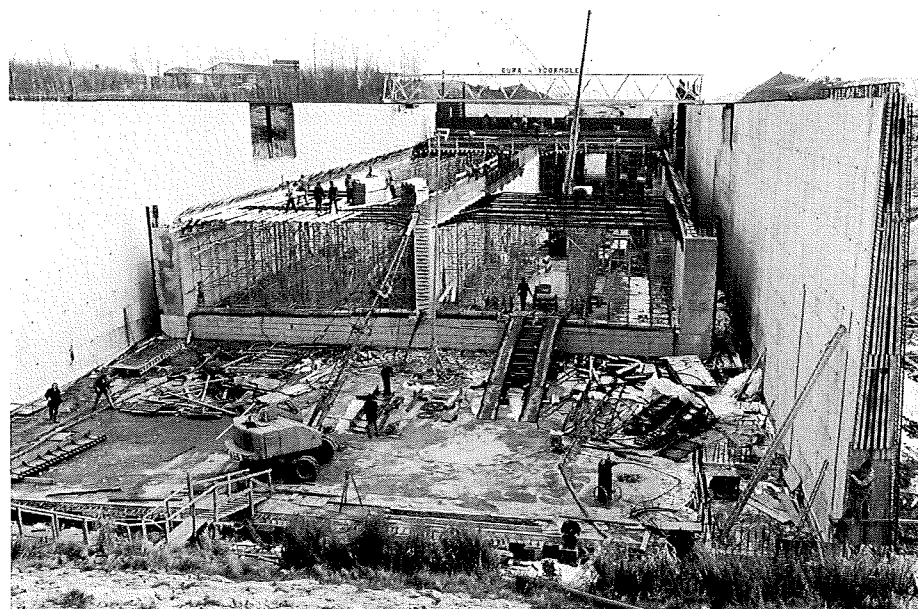
Stand werkzaamheden begin maart '76 Photograph, dated March 1976
