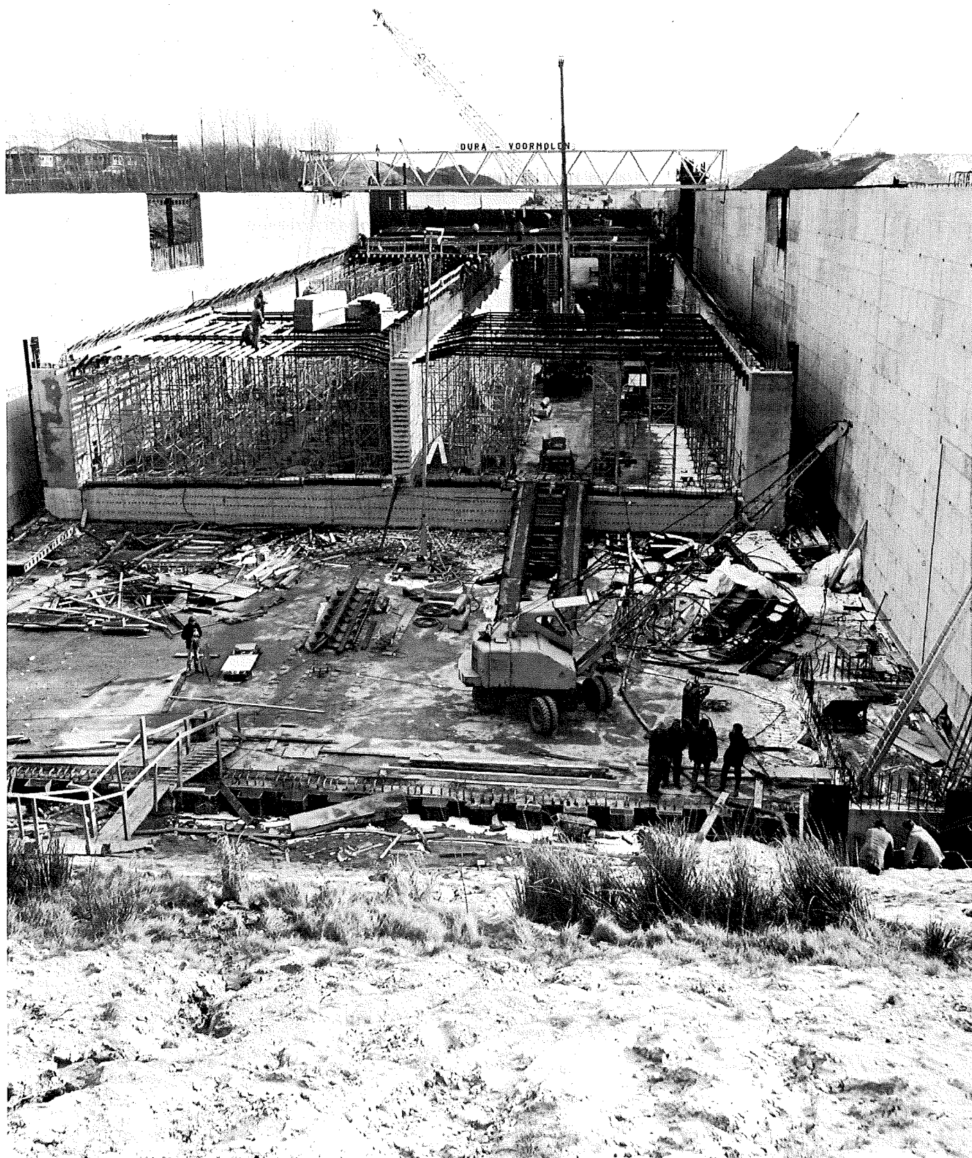
Een bijzondere bouwplaats voor een tunnelement: de aansluitende afrit foto: Cement/Bob de Ruiter
