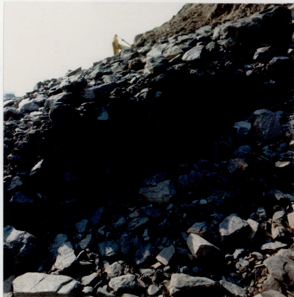
foto 10 Sleufwand na uit- spoeling fijn ma- teriaal door getij (ca. 3 dagen na graven sleuf)
