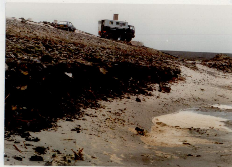
foto 13 Weggedruken peilbuis; kraagstuk en gedeelte van teencon- structie al opgeruimd
