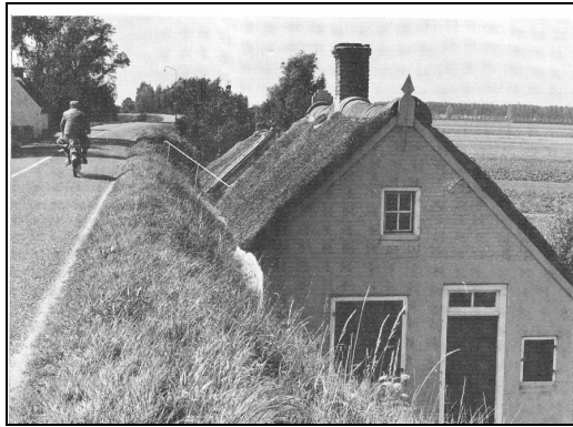
Figuur 2-3: Links: Door het toepassen van een te grote veiligheidsmarge moeten er misschien onnodig huizen gesloopt worden (bron: [Swart, 1975]). Rechts: Een te kleine veiligheidsmarge leidt sneller tot een dijkdoorbraak (bron: [CUR 162, 1992])
