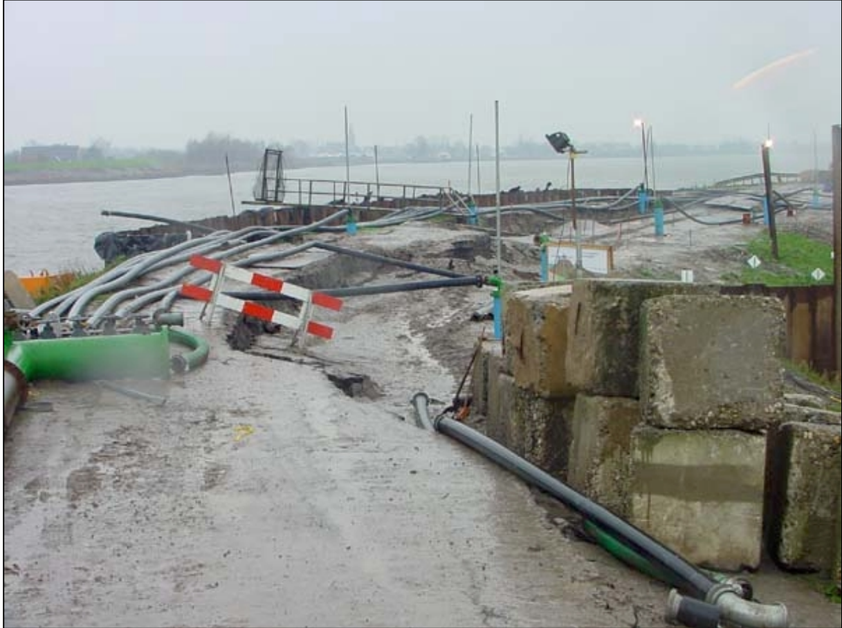
Figuur 2-1: Afschuiven binnentalud lekdijk bij Bergambacht tijdens bezwijkproef. (Bron DWW (Rijkswaterstaat): http://www.minvenw.nl/rws/dww/lekdijk ).
