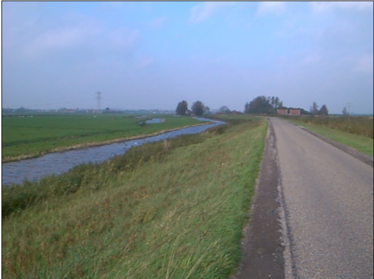
Figuur 2-2: Boezemkade die ondanks een 'veel te lage' stabiliteitsfactor van 0,5 (berekend volgens vigerende leidraden) toch blijft staan. (Bron: [FUGRO, 2002])
