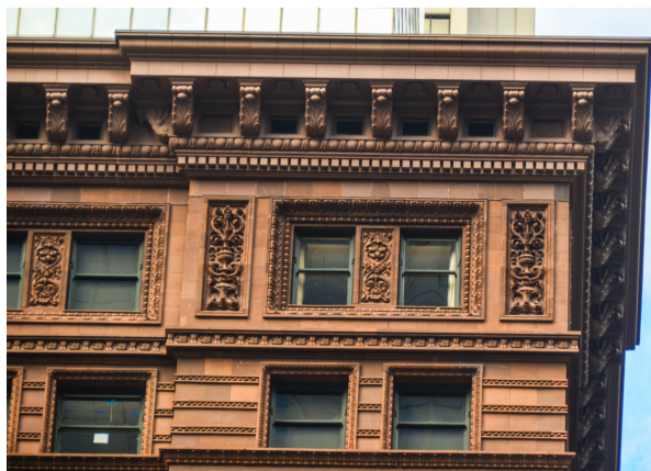
Detail van de Marquette Building, Chicago, gebouwd door Hollabird & Roche in 1895 (Rogers, 2013)
