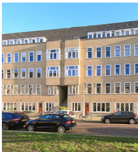
Figuur 36 Amsterdamse school in het Merwedeplein
