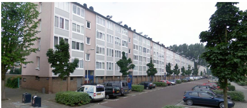
Figuur 9. Voorbeeld portieketageflat in Amsterdam Nieuw West. Bron: Google Maps, street view
