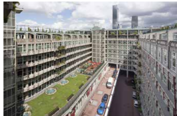
Figure 4.76 Internal courtyards of Groot Handelsgebouw (Kokon, 2020).
