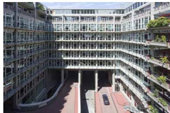
Figure 4.77 Internal courtyards of Groot Handelsgebouw (Kokon, 2020).
