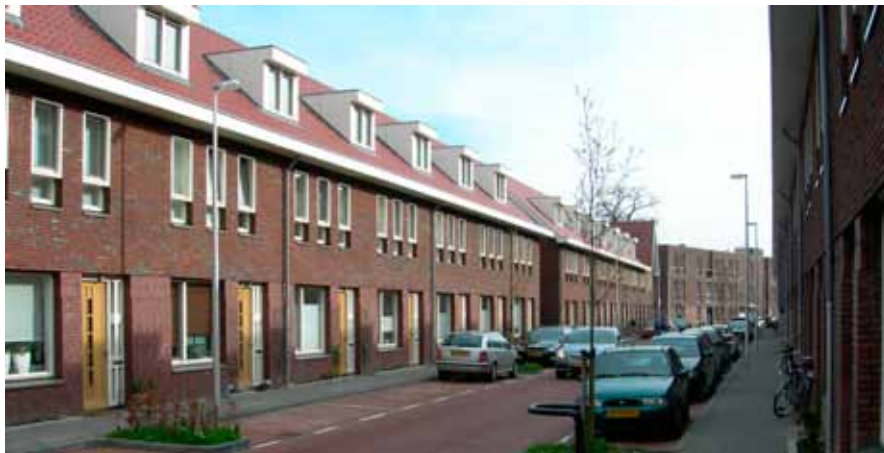
De nieuwe rijwoningen in de Noordzeestraat
