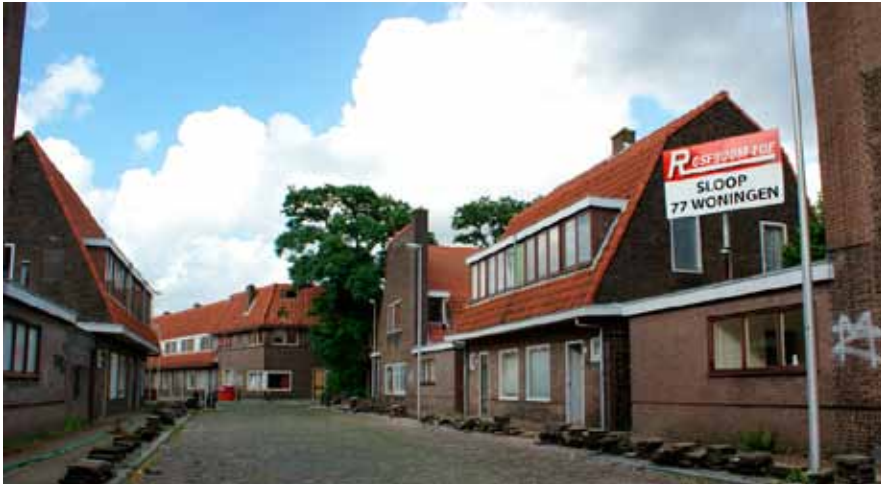
De woningen in de Noordzeestraat vlak voordat ze gesloopt worden (foto: Uitdra-gerij)
