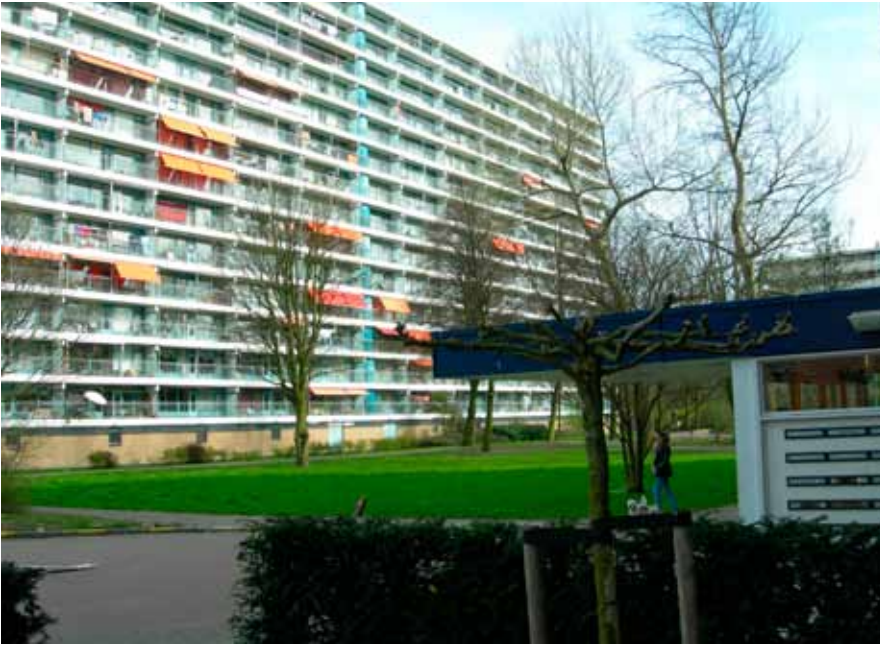
Achterzijde van de Eliotflat. Rechts op de voorgrond is de ingang van complex Nijeveld zichtbaar
