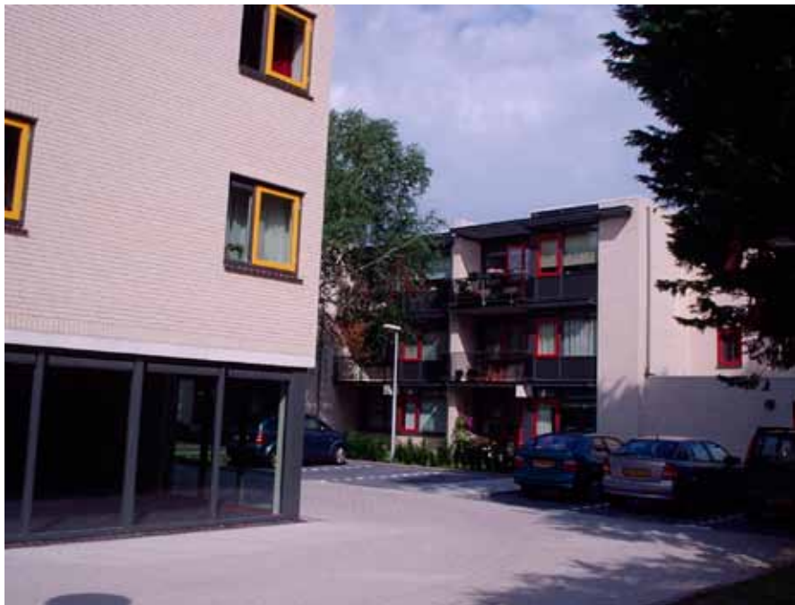
Gebouwen van het Beuckelaercomplex na de renovatie
