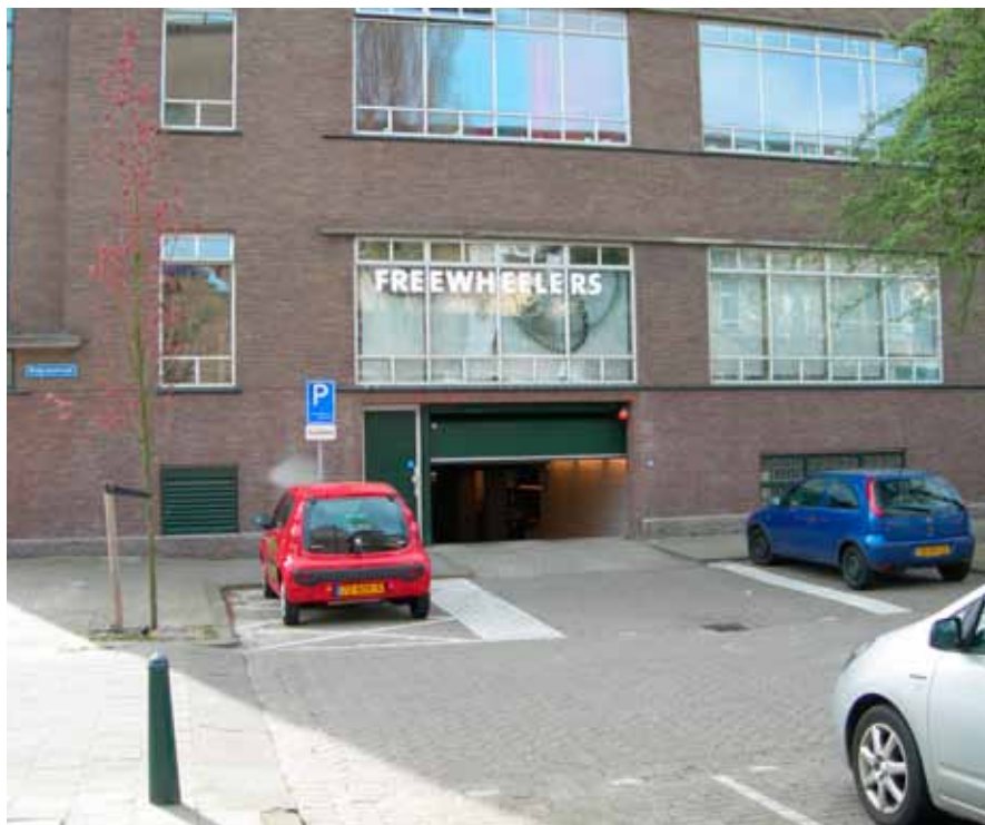
Ingang van de parkeergarage onder het gebouw aan de Walenburgerweg
