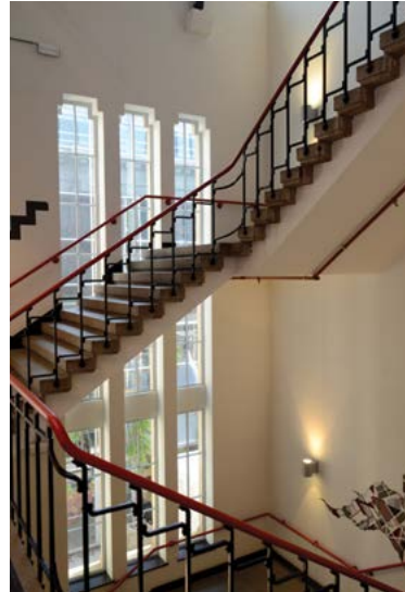
Figuur 8: Eén van de monumentale trappenhuizen met granieten treden en een smeedijzeren hekwerk. Foto: Wido Quist (2021)
