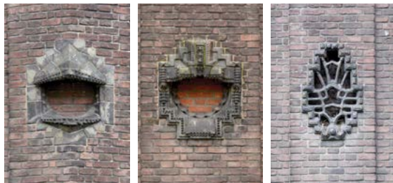
Figuur 3: Drie verschillende uitvoeringen van decoratieve keramische elementen, ontworpen om de luchtuitlaten van de zuurkasten te ‘maskeren’. Foto’s: Wido Quist (2021)
