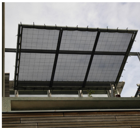
Figuur 47a Toegevoegde zonwering, lichthoven
