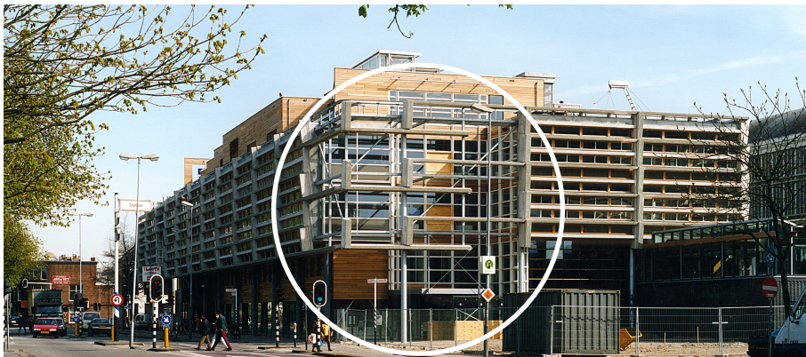
Figuur 20 De in de ruimte zwevende betonnen pui bij de entree (bron: Uytenga Architecten)
