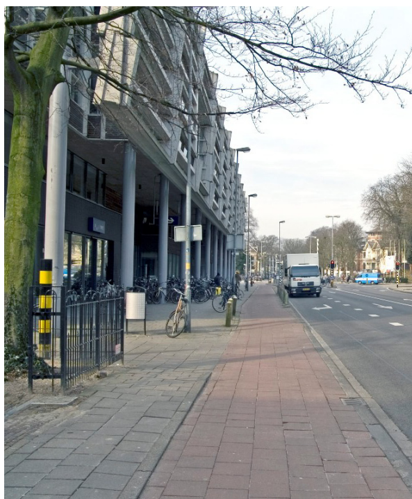
Figuur 35a Kolommen aan buitenzijde gebouw
