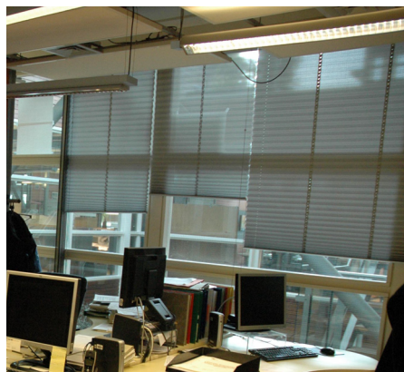
Figuur 47b Provisorisch opgehangen zonwering
