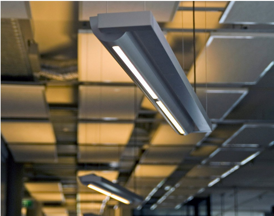
Figuur 46 Ophanging verlichtingsarmatuur
