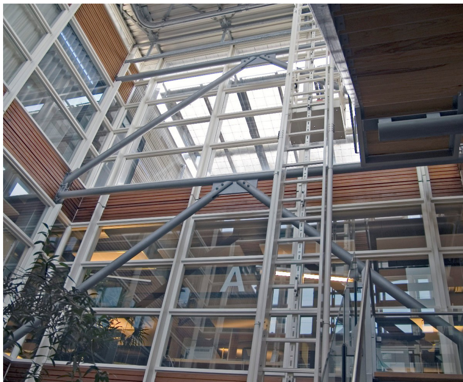
Figuur 9 Stalen windverbanden in het atrium
