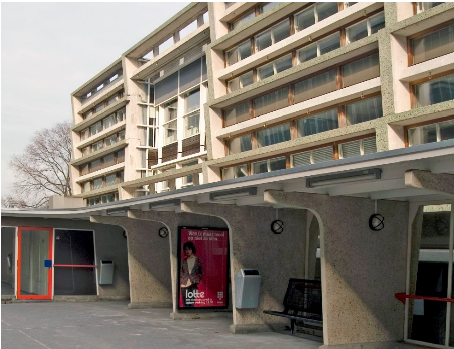
Figuur 7 Aanzicht Noordgevel vanaf het stationsperron
