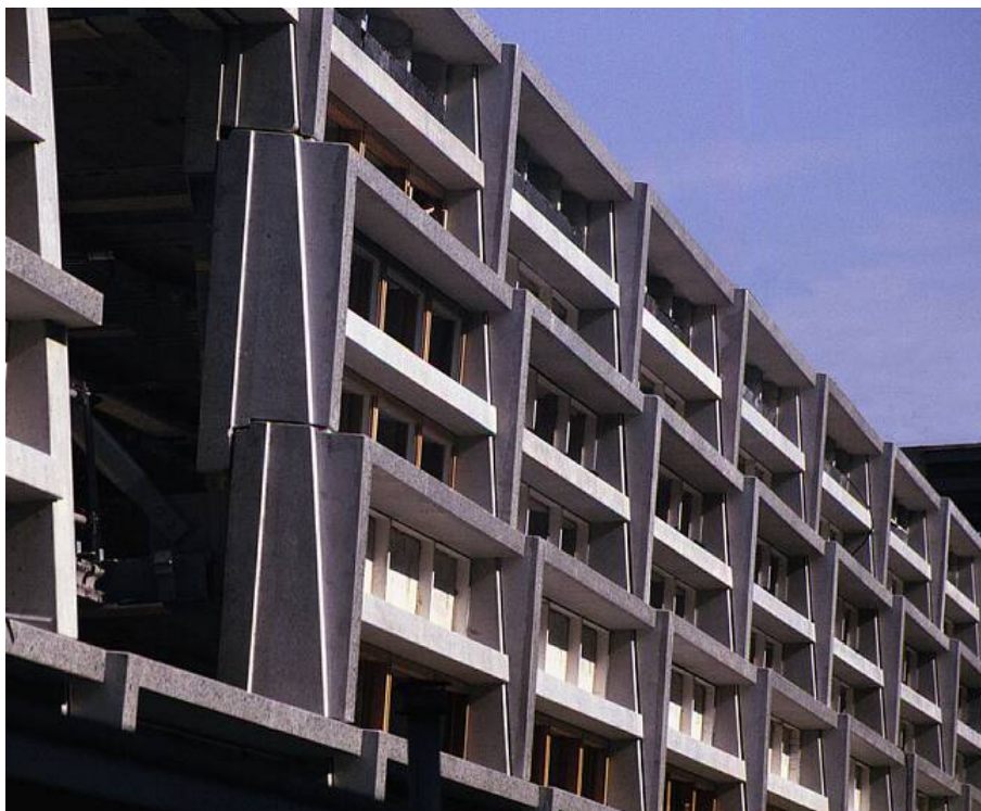
Figuur 24 Betonnen gevelementen
