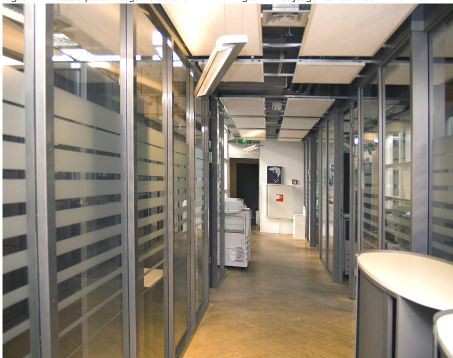
Figuur 73 Mattering op de wanden
