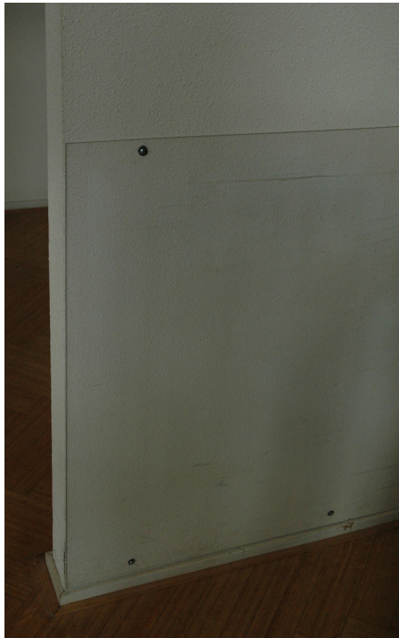
Figuur 42 Stootbescherming op binnenwand
