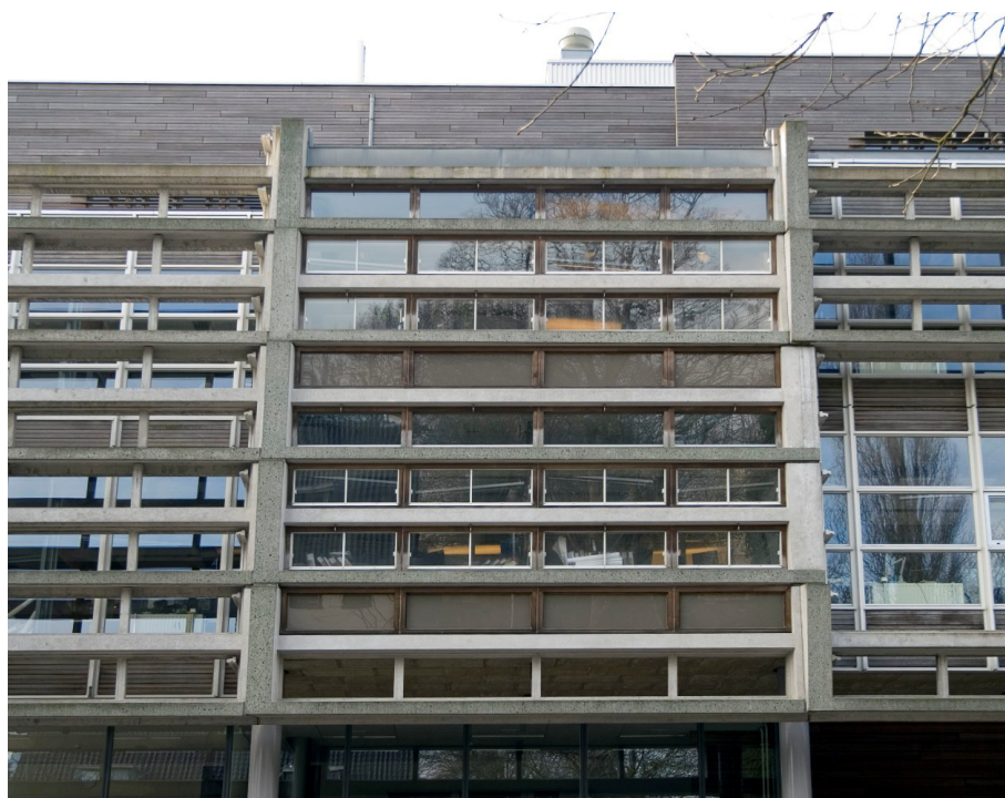
Figuur 37 Betonnen brise-soleil met daartussen ramen
