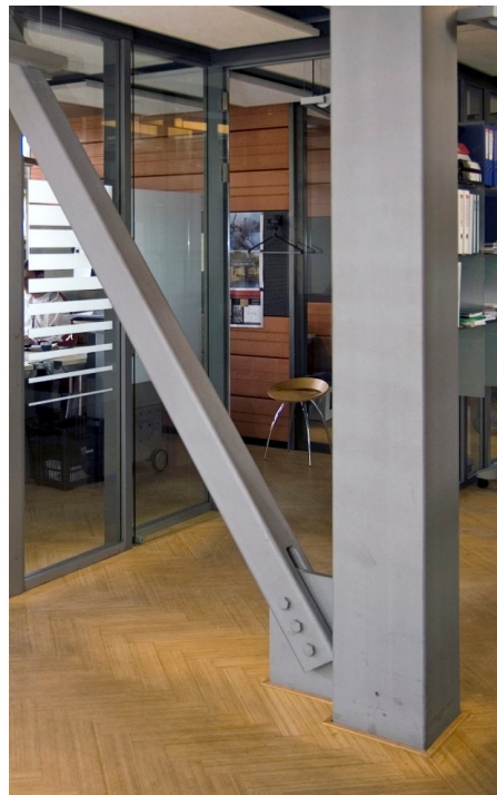
Figuur 34 Uiteindelijke uitvoering verbinding
