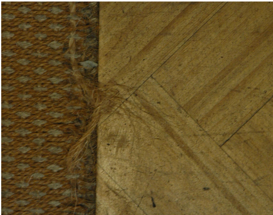
Figuur 43 Overgang tussen vloerbedekkingen
