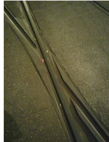
Figuur 2.15 Sprong in groefdiepte (Constantin, 2016)
