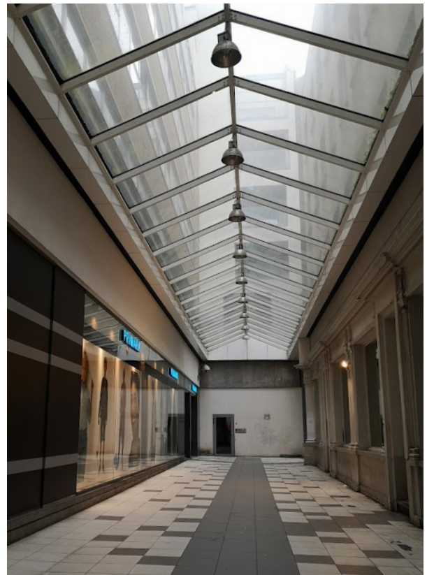
Passage Rue d'Argent
