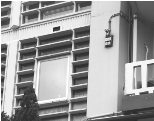
Afbeeldingen 4.2.161 en 162: de leidingen die in de loop der tijd werden aangebracht op de gevel en zoveel mogelijk in 2004 weer werden verwijderd. H. Zijlstra 2002.
