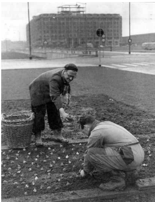
Afbeelding 4.2.5: tulpenbollen worden geplant op het Weena in 1952, met het Groothandelsgebouw in aanbouw op de achtergrond. Boddaert, J., Weena , Rotterdam 1997, foto: Daniel van de Ven.
