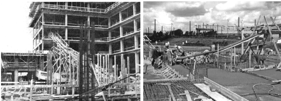
Afbeeldingen 4.2.199 en 200: de toepassing van de betonpomp bij het Groothandelsgebouw, een technische noviteit waar Maaskant in zijn publicaties melding van maakte. Tate, J.L., 'Het Groothandelsgebouw te Rotterdam', Polytechnisch Tijdschrift , (1951) 43-44, pp. 693b-699b. Vroegindewij, R. en C. Boekraad, Groothandelsgebouw 1948 – 2003 , Rotterdam 2003.
