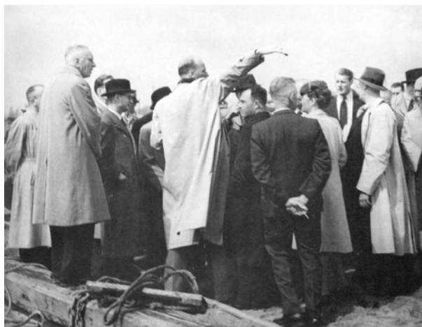
Afbeelding 4.2.205: Maaskant geeft uitleg bij het Groothandelsgebouw in aanbouw. Ott, L., Van luchtkasteel tot koopmansburcht , Rotterdam 1969.
