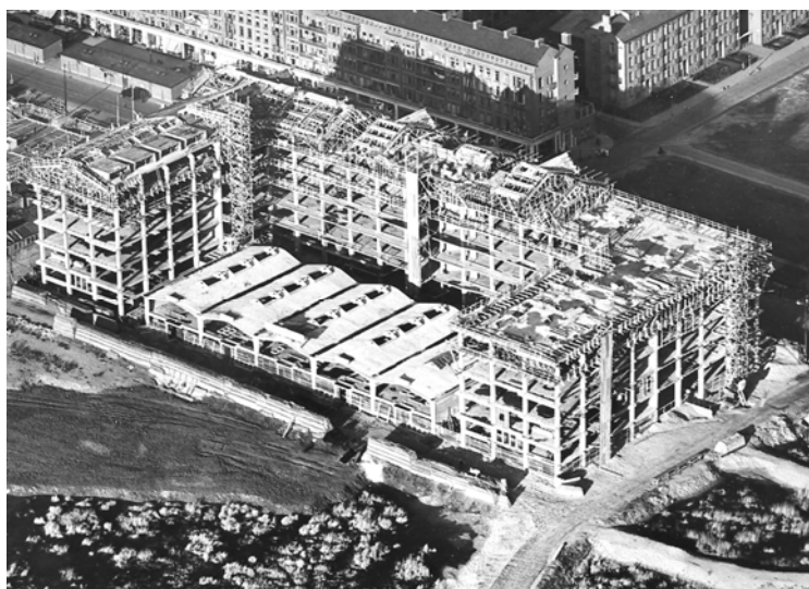
Afbeelding 4.2.41: het industriegebouw aan de Goudsesingel in aanbouw. Archief De Kondor, NAI.
