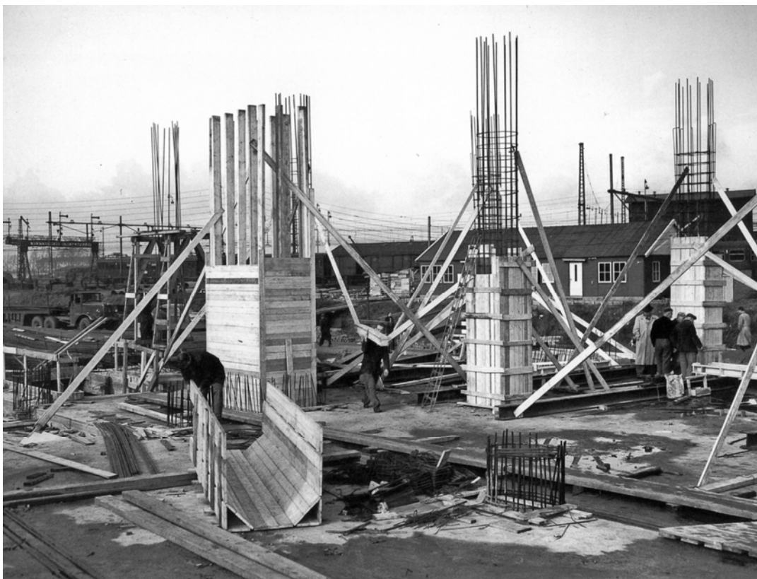
Afbeelding 4.2.93: de bekisting van de achthoekige kolommen. Vroegindeweij, R. en C. Boekraad, Groothandelsgebouw 1948-2003 , Rotterdam 2003.
