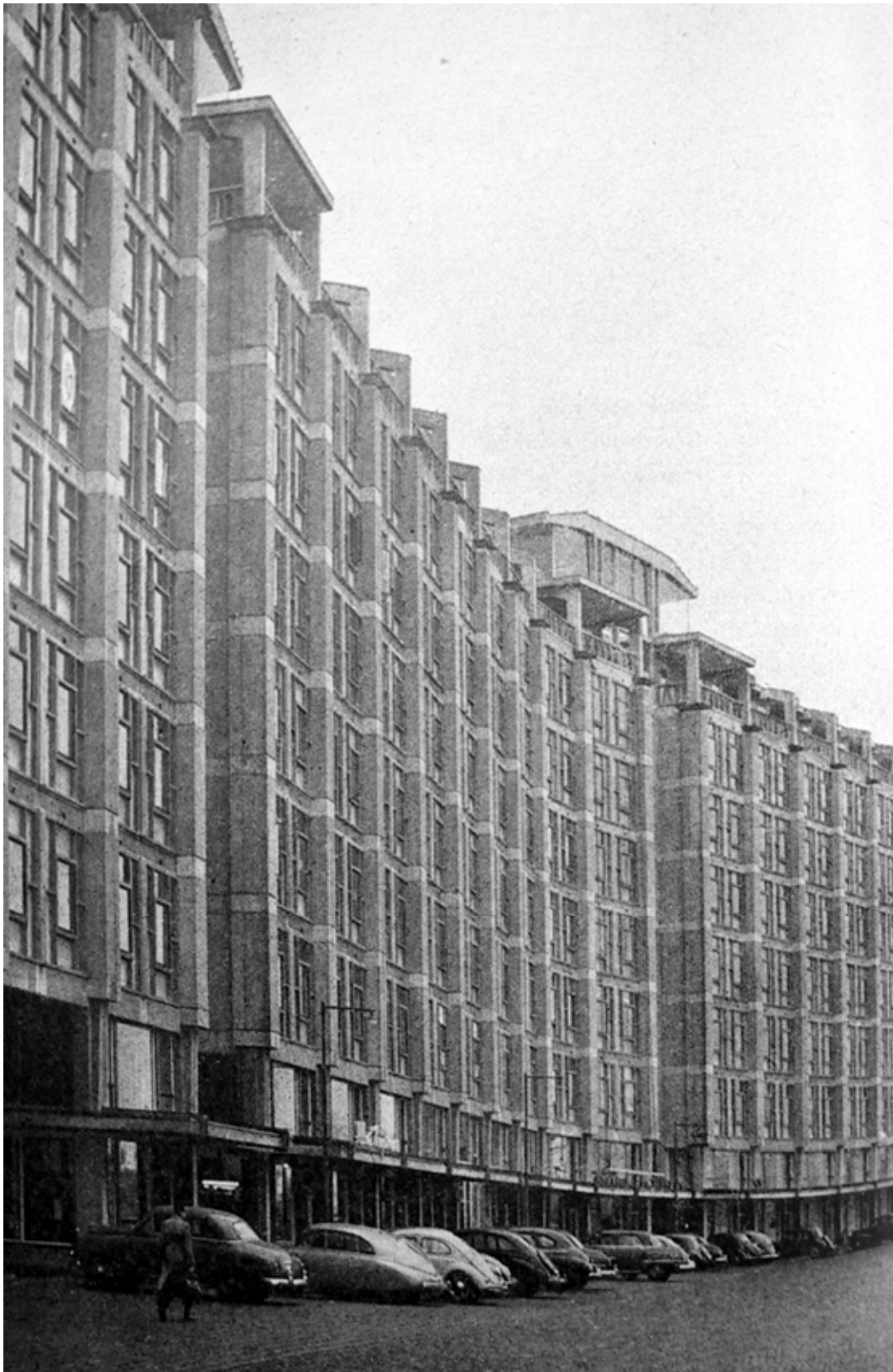
Afbeelding 4.2.76: de gevel aan de Conradstraat laat duidelijk de structuur zien van trappenhuizen en de verticale kolommen. Groothandelsgebouwen N.V. , Herfst 1951. (NAI)
