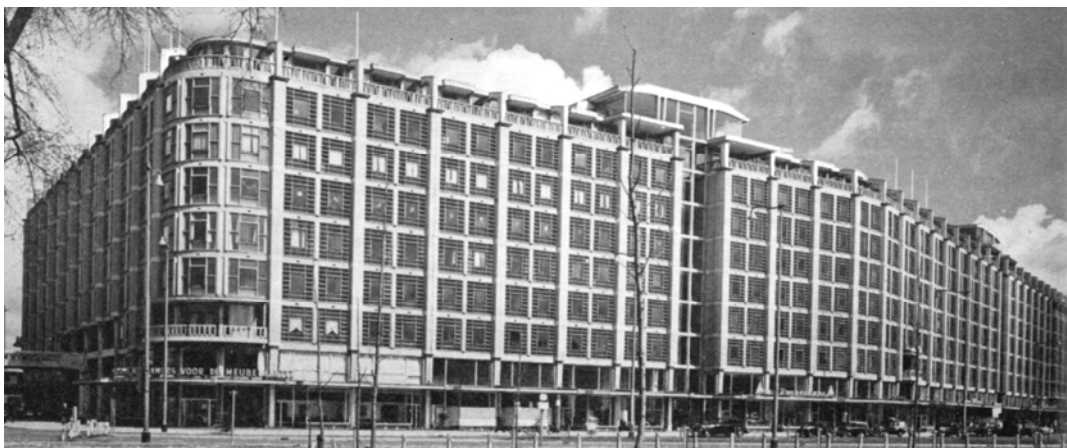
Afbeelding 4.2.62: de gevel aan het Weena met de uitgesneden trappenhuizen. Maaskant, H. A., 'Verzamelgebouwen', Forum , (1953) 4-5, pp. 130-137.
