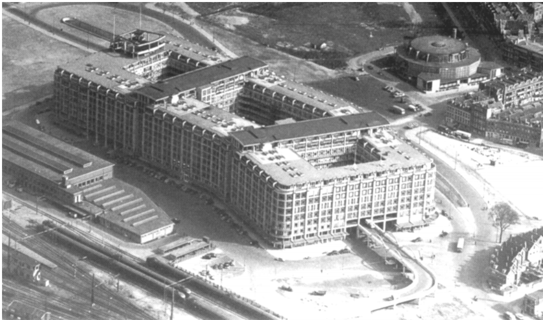
Afbeelding 4.2.59: een luchtfoto van het Groothandelsgebouw waarbij de opbouw van het volume goed te zien is: een gesloten ring waartussen twee hogere dwarsblokken liggen. Bulthuis, P en C. Dijk, 50 jaar Groothandelsgebouw , Rotterdam 2003.
