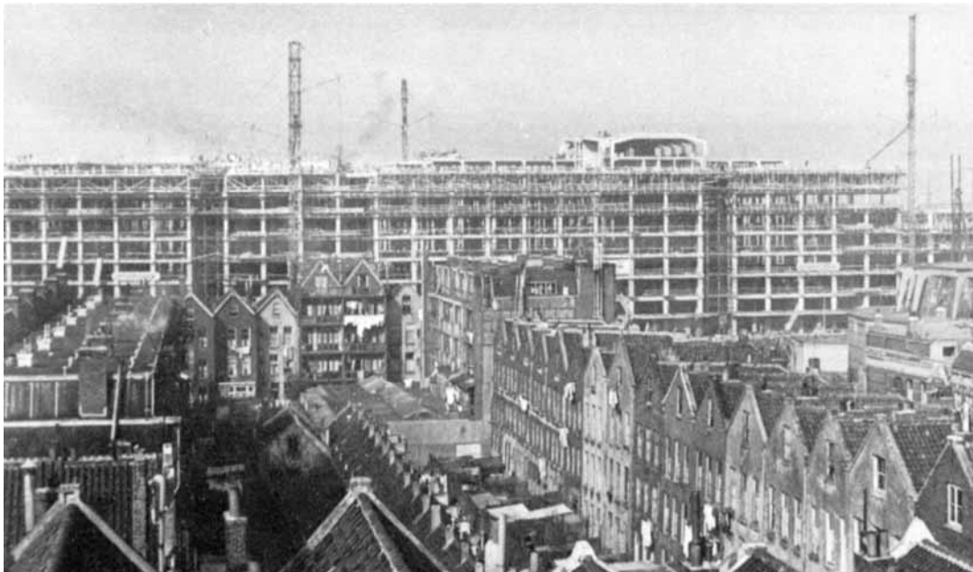
Afbeelding 4.2.75: de draagconstructie van het Groothandelsgebouw in aanbouw. Beeren W.A.L., Bouwen in Rotterdam 1920-1960 , Museum Boymans - van Beuningen Rotterdam, Delft 1982.
