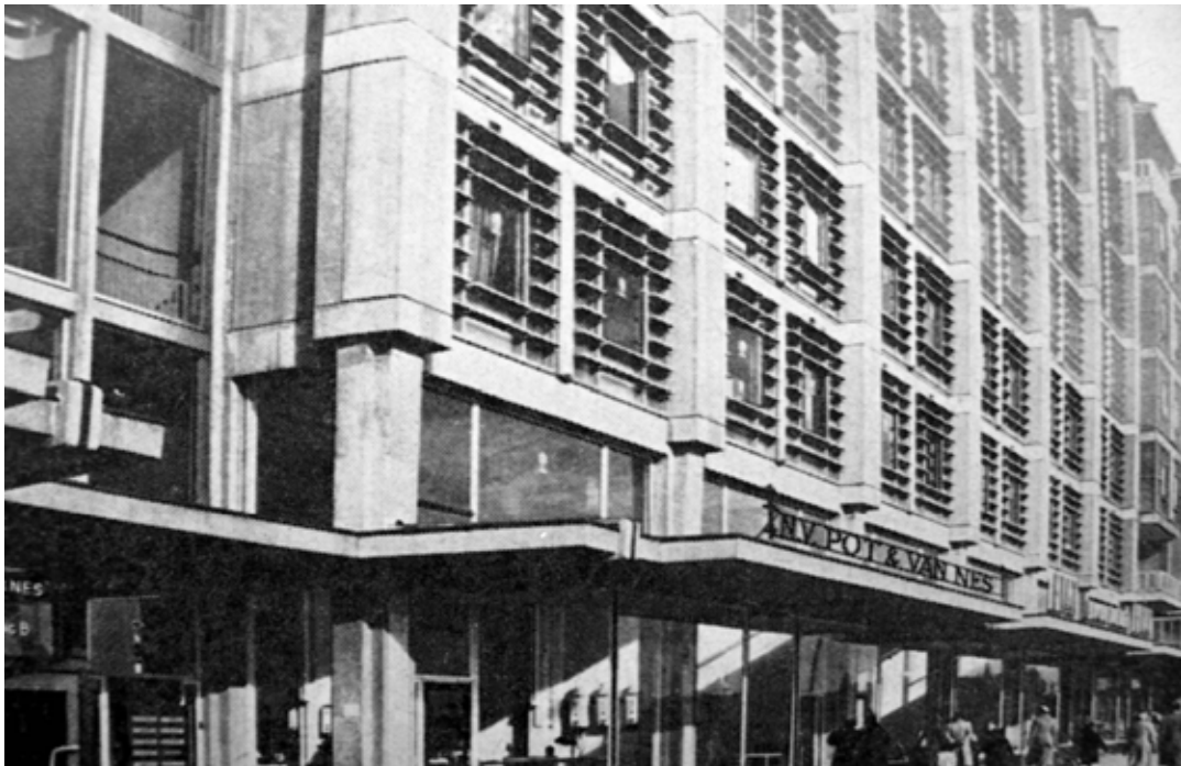
Afbeelding 4.2.123: de stalen etalagepuien lopen achter de luifels door. 'Van idee tot werkelijkheid, Groothandelsgebouw, trots van Rotterdam' , Rotterdam 1952. Brochure deel 1. Algemeen, deel 2: firma Pot & van Nes, deel 3 Rizla. (GAR)
