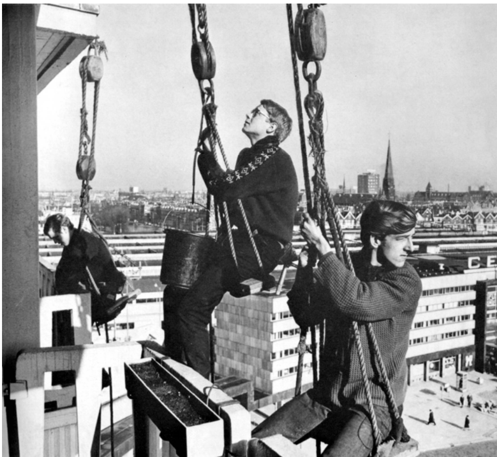
Afbeeldingen 4.2.135 en 136: een onderstation voor de centrale verwarming en de glazenwassers in actie. Ott, L., Van luchtkasteel tot koopmansburcht , Rotterdam 1969.
