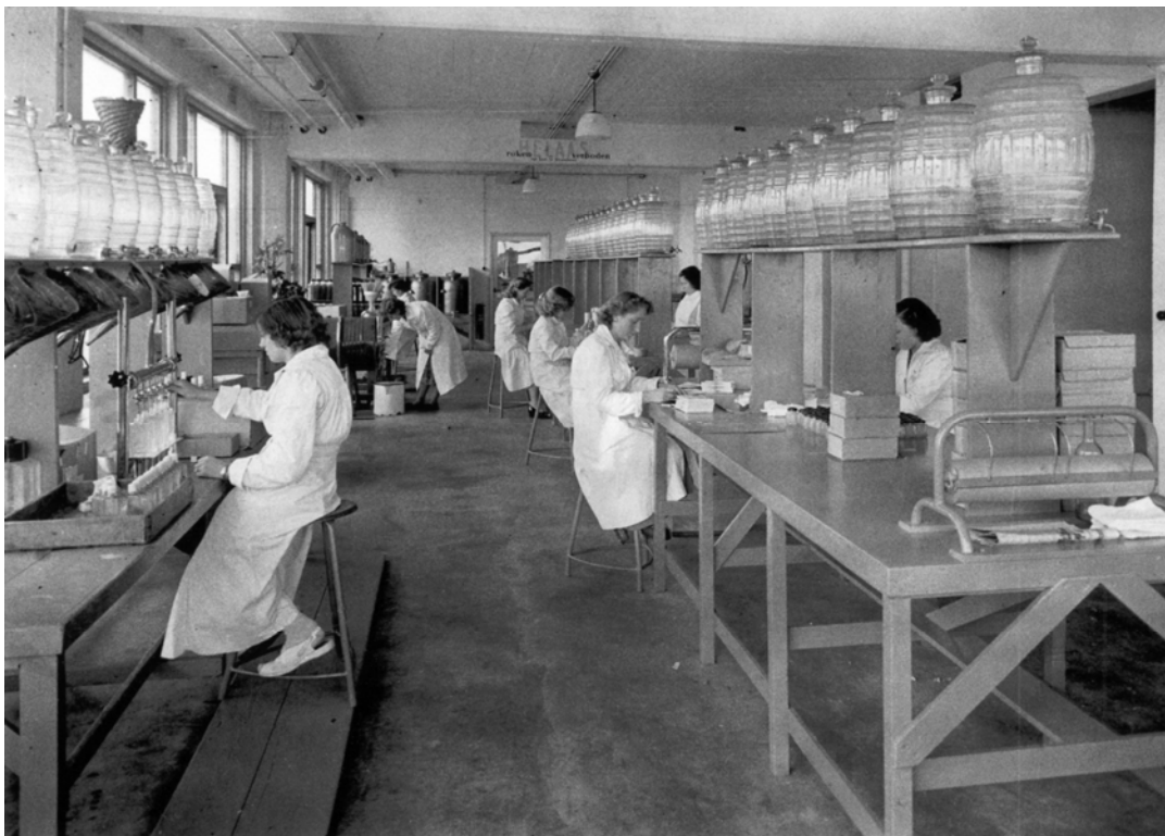
Afbeeldingen 4.2.137 en 138: het Groothandelsgebouw in gebruik. De ruimten werden kaal opgeleverd en meestal ook zo gebruikt. In de balken zijn de spelingen te zien voor de leidingen. Vroegindewij, R. en C. Boekraad, Groothandelsgebouw 1948-2003 , Rotterdam 2003.
