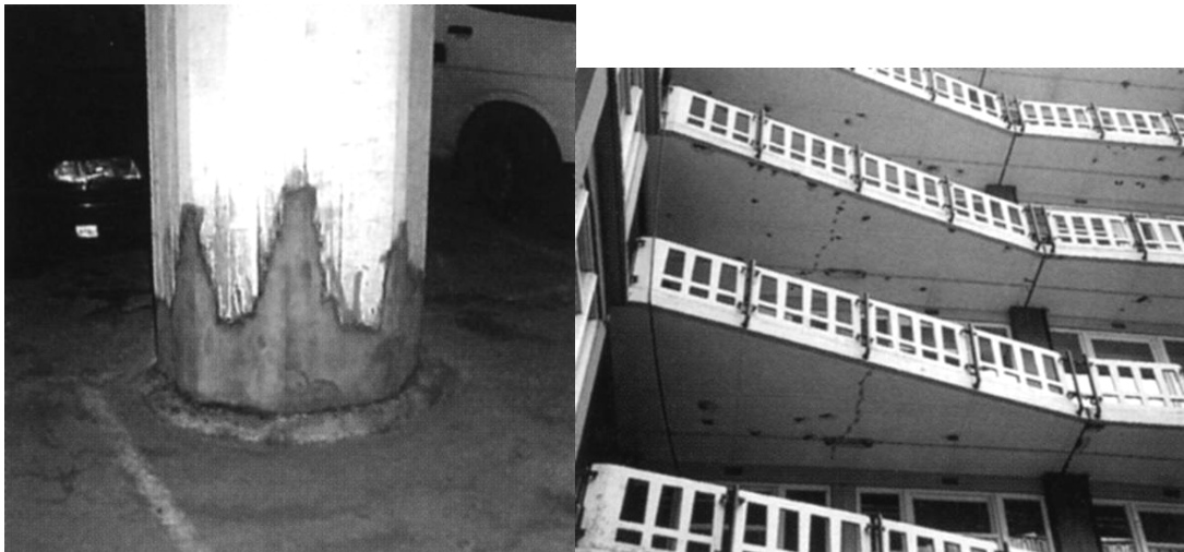
Afbeeldingen 4.2.149 en 150: de herstelde kolomvoet in de kelder en de te repareren scheuren in de galerijvloeren. Vries, T. de, 'Betonconstructies in het groothandelsgebouw', Renovatie & Onderhoud , (2000)juni, pp. 18-21.
