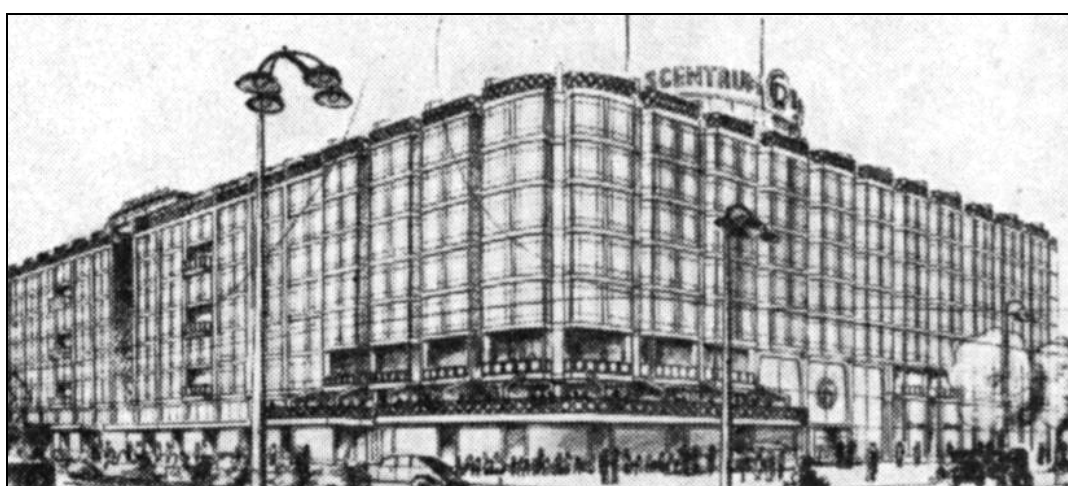
Afbeelding 4.2.114: de gevels getekend in 1948, aan het Weena, met balkons en erkers, en aan het Stationsplein over de volle lengte met erkers die tot de daklaag doorlopen. Maaskant, H. A. en W. van Tijen, 'De betekenis van het Rotterdams Groothandelsgebouw', Polytechnisch Tijdschrift , (1949) 11/12, pp. 171b-177b.
