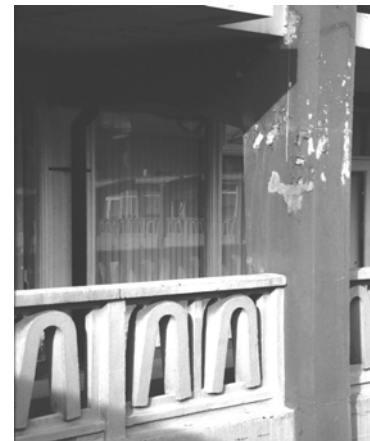
Afbeeldingen 4.2.157 en 158: het verschil tussen monoliet gestorte en stapel constructie in beton en de herhaaldelijk geschilderde beton elementen die oorspronkelijk in schone beton waren uitgevoerd. Maaskant, H. A., 'Groothandelsgebouw Rotterdam', Bouw , (1951) 13, pp. 217-221. H. Zijlstra 2002.
