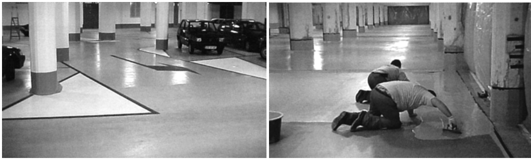
Afbeeldingen 4.2.151 en 152: de nieuwe gietvloer in de parkeerkelder. Vries, T. de, 'Beton-constructies in het groothandelsgebouw', Renovatie & Onderhoud , (2000)juni, pp. 18-21.
