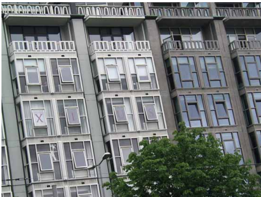
Afbeeldingen 4.2.187-189: de gevels tijdens de reinigingsoperatie. Onder: links de oude gevel en rechts de nieuwe gevel volgens de plannen van Van Stigt uitgevoerd (boven andersom). De gevels werden donkergrijs en het glas vertoont een blauwe spiegeling. H. Zijlstra 2004.
