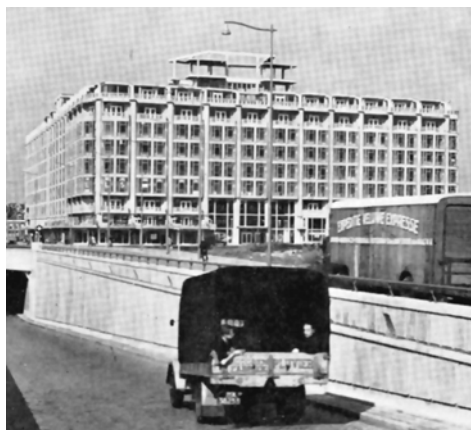
Afbeeldingen 4.2.57 en 58: het Groothandelsgebouw met een op het dak het nog open skelet van de latere bioscoopzaal Kriterion en de vijf aannemers op het bouwboard. Maaskant H. A., 'Architectonische verantwoording', Bouw , (1953) 9, pp. 150-153.
