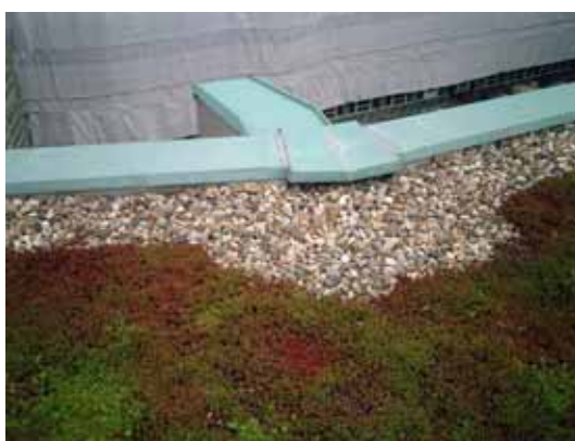
Afbeeldingen 4.2.172-175: de luifels werden volgens de plannen van Van Stigt gezandstraald, van een dunne cementlaag voorzien en met koper afgedekt. Op het dak ligt grind en sedum. H. Zijlstra 2004.
