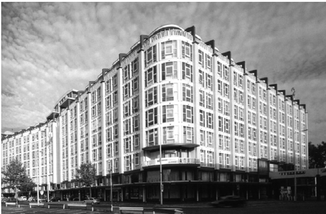
Afbeeldingen 4.2.118 en 119: de hoek Weena – Stationsplein werd uitbundiger, belangrijker, uitgewerkt dan de hoek aan de Conradstraat. Ploeg, G. (red), 100 jaar hoogbouw in Rotterdam. Zoiets Amerikaansch! , Rotterdam 1999. Bulthuis, P en C. Dijk, 50 jaar Groothandelsgebouw , Rotterdam 2003.
