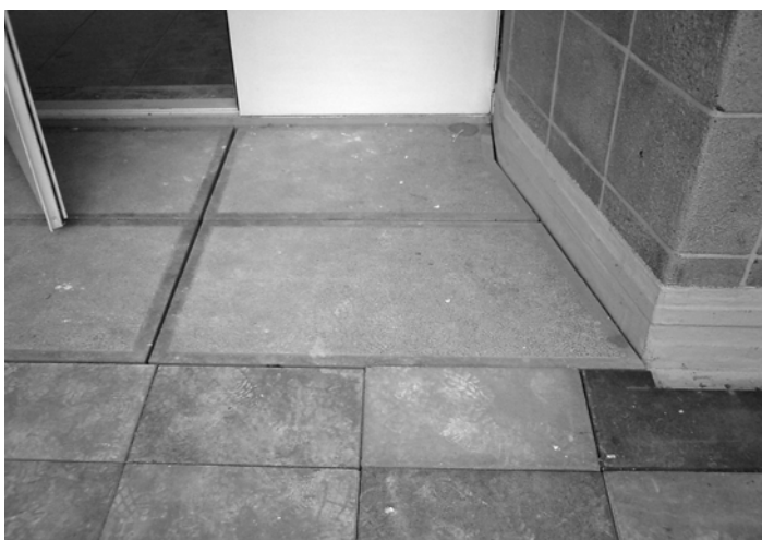
Afbeelding 4.2.190: de aansluiting van de vloerafwerking op de galerij, nieuwe tegels van beton sluiten aan op oude platen van natuursteen. H. Zijlstra 2004.
