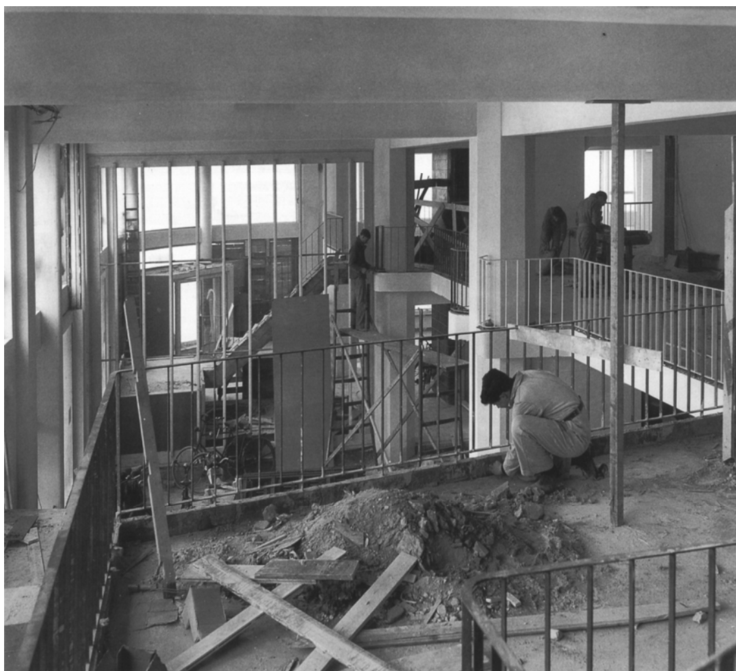
Afbeelding 4.2.130: het aanbrengen van de cement dekvloeren op de entresol verdieping. Vroegindeweij, R. en C. Boekraad, Groothandelsgebouw 1948 – 2003 , Rotterdam 2003.
