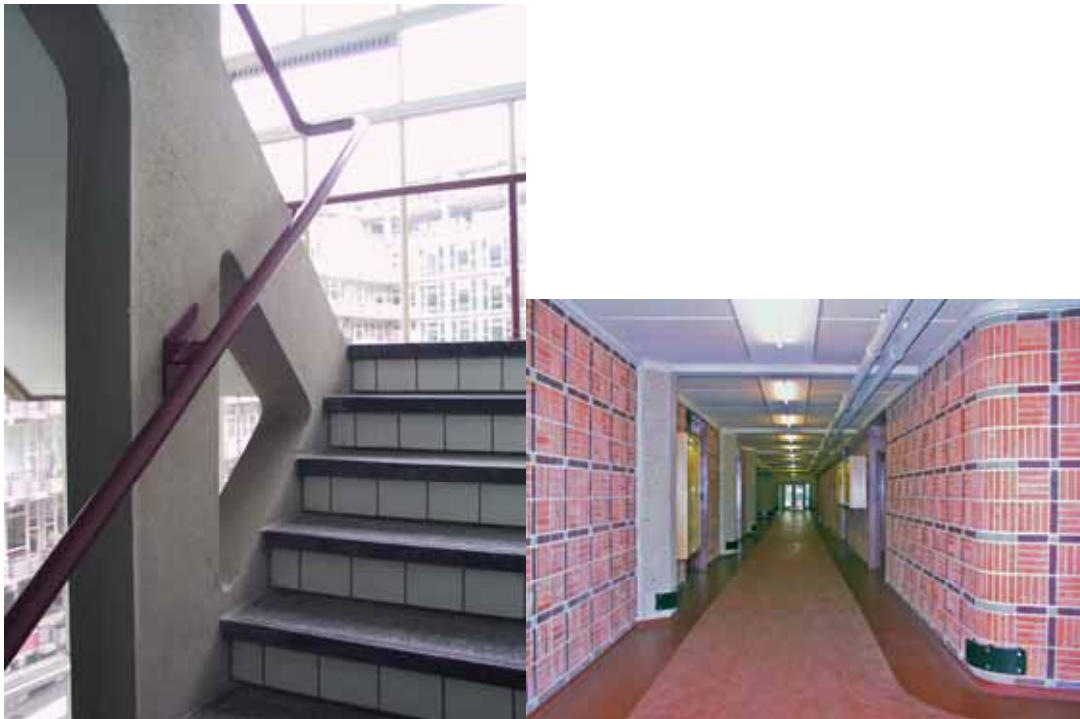
Afbeeldingen 4.2.131 en 132: de afwerking van de trappen en een gang. H. Zijlstra 2004.
