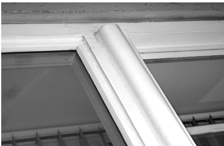
Afbeeldingen 4.2.126-128: de houten puiken aan de galerijen in de binnenhoven. Vlak gedetailleerde puiken boven gemetselde borstweringen en de middels een ronde koppellat geschakelde puiken met borstweringselementen van draadglas in de puiken. H. Zijlstra 2002.
