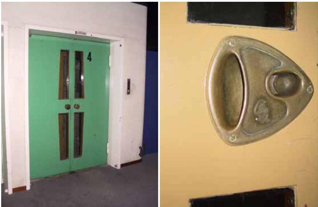
Afbeeldingen 4.2.133 en 134: de oorspronkelijke deuren van de liften. H. Zijlstra, 2002.
