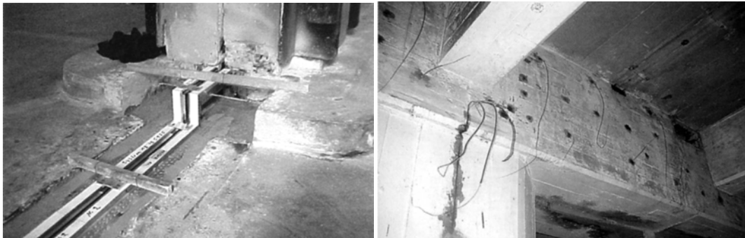
Afbeeldingen 4.2.147 en 148: de goot ter plaatse van de dilatatie werd dicht gestort en van nieuwe profielen voorzien en de aantasting van het beton in balken en kolommen werd gestopt. Vries, T. de, 'Betonconstructies in het groothandelsgebouw', Renovatie & Onderhoud , (2000)juni, pp. 18-21.
