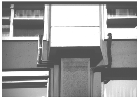
Afbeeldingen 4.2.161 en 162: de leidingen die in de loop der tijd werden aangebracht op de gevel en zoveel mogelijk in 2004 weer werden verwijderd. H. Zijlstra 2002.
