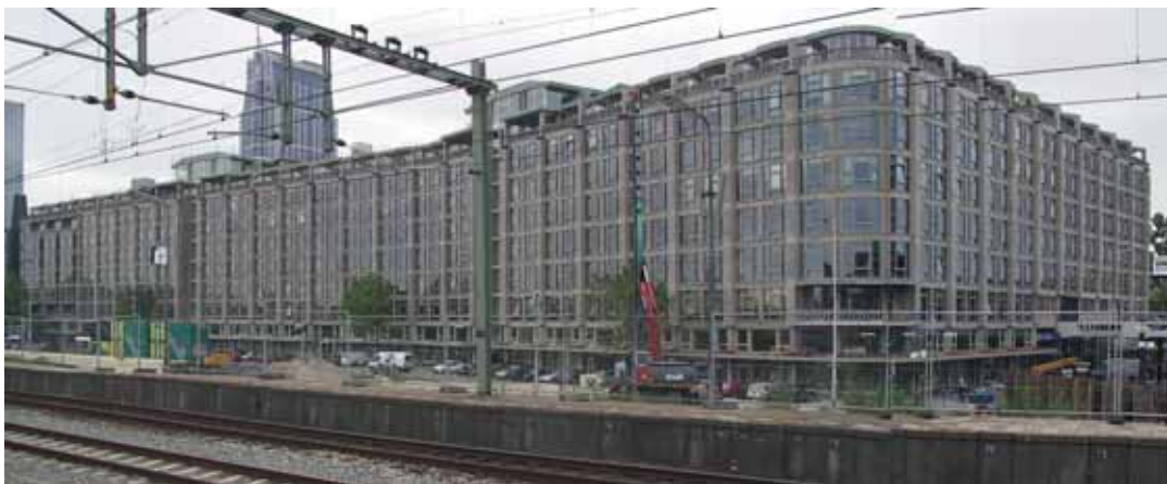
Afbeelding 4.2.212: het Groothandelsgebouw wederom donkergrijs, na het reinigen van de gevels. H. Zijlstra 2004.
