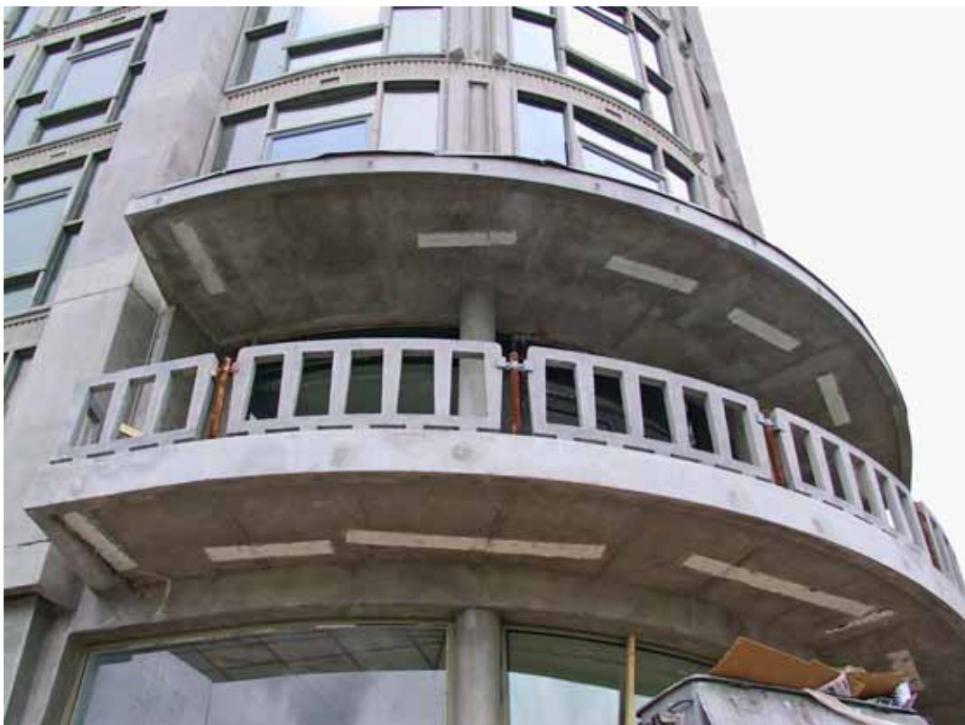
Afbeeldingen 4.2.184-186: de gevels tijdens de schoonmaak operatie en de luifels die geheel met cement werden afgewerkt. H. Zijlstra 2004.
