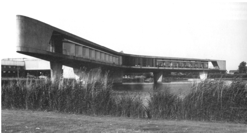
Afbeelding 4.2.30: het Johnson Wax gebouw bij Mijdrecht. Idsinga T., J. Schilt, Architekt W. van Tijen 1894-1974 , 's-Gravenhage 1987.
