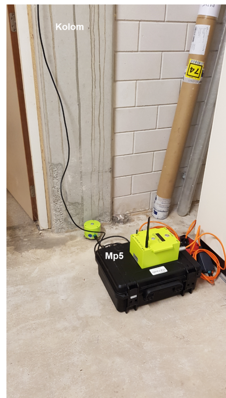
(b) Locatie MP5 nabij kolom in de verkeersleidingspost.
