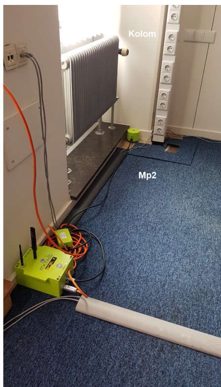
(a) Locatie MP2 nabij kolom in de verkeersleidingspost.
