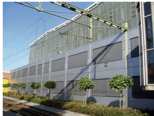
(3) Situation before reuse © Rijksbouwmeester Atelier.
