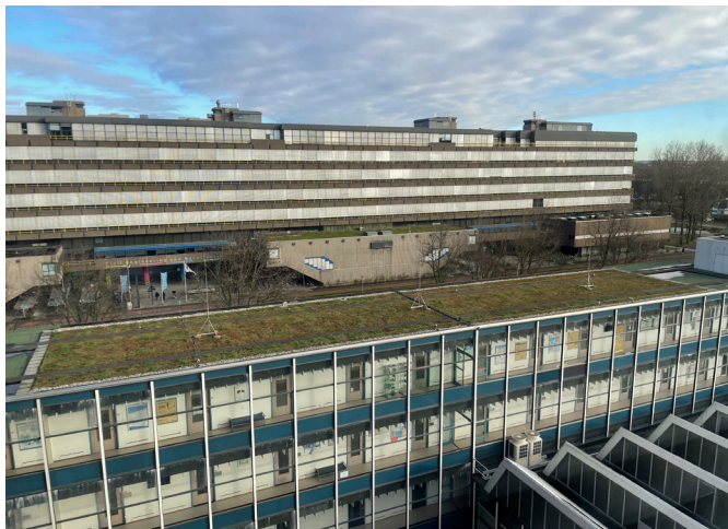
Figuur 2.6 - Groen dak op laagbouw
