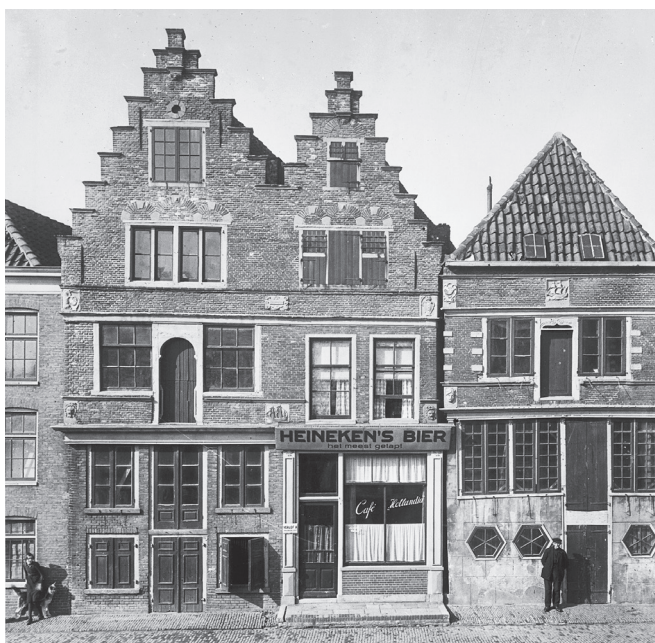
Figuur 3.1 - Oude Doelenkade 17-19 voor de restauratie (RCE, 1930)
