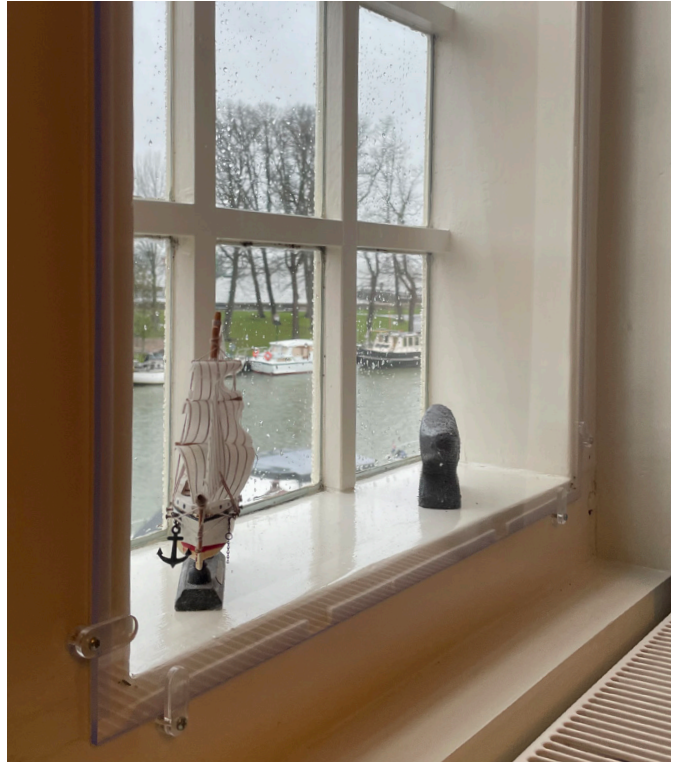
Figuur 3.3 - Achterzetramen plexiglas op de eerste verdieping
