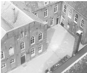
Image 38 Hubertusgebouw, the facade facing Nieuwstadskerk.
