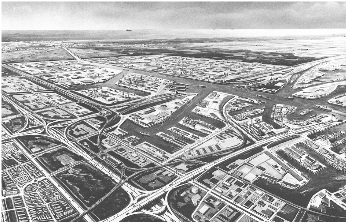
Figure 16 "Het Westelijk Havengebied in 1980" (Giljamse et al., 2009, p. 256)
