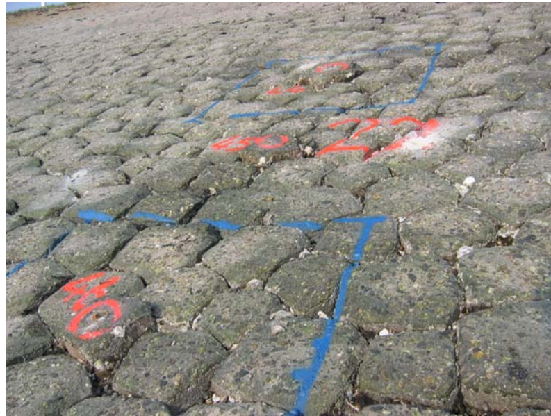
Foto 6-3 Basalton zuilen in Poortvliet
