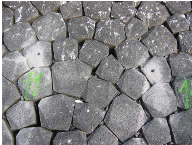
Figuur 6-10 Basalton stenen in Sluis, hier proef TC11
