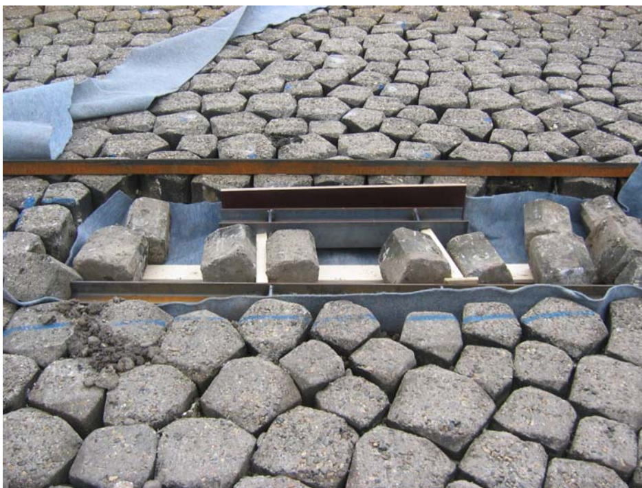
Foto 4-9 De sparingen (tussen betonplex en textiel wordt beton ingegoten):
