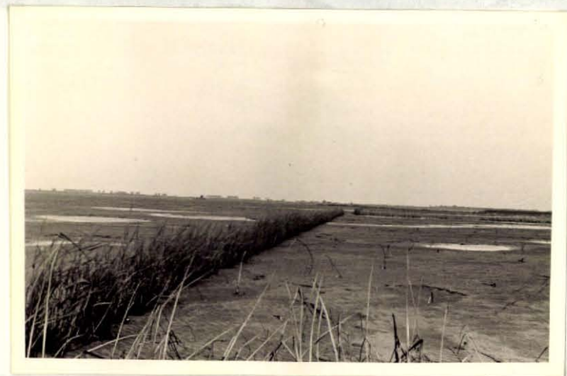
3. Hellegatplaat. Levend scherm van spartinagrass.
