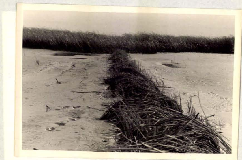
13. Rest van dammetje no. 11 na eenige weken slecht weer. De constructie is voor het Hellegat te simpel en zwak.
