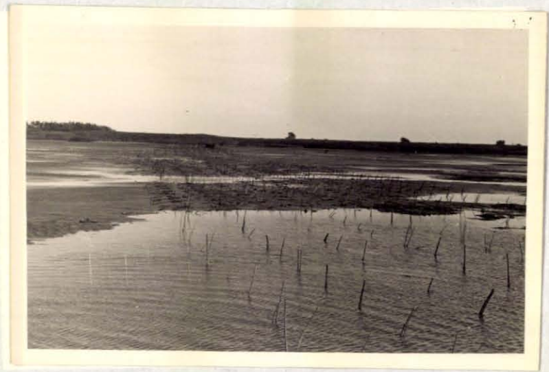
5. Maartensgat. Breed scherm van biesstekken, onmiddellijk na den aanplant.
