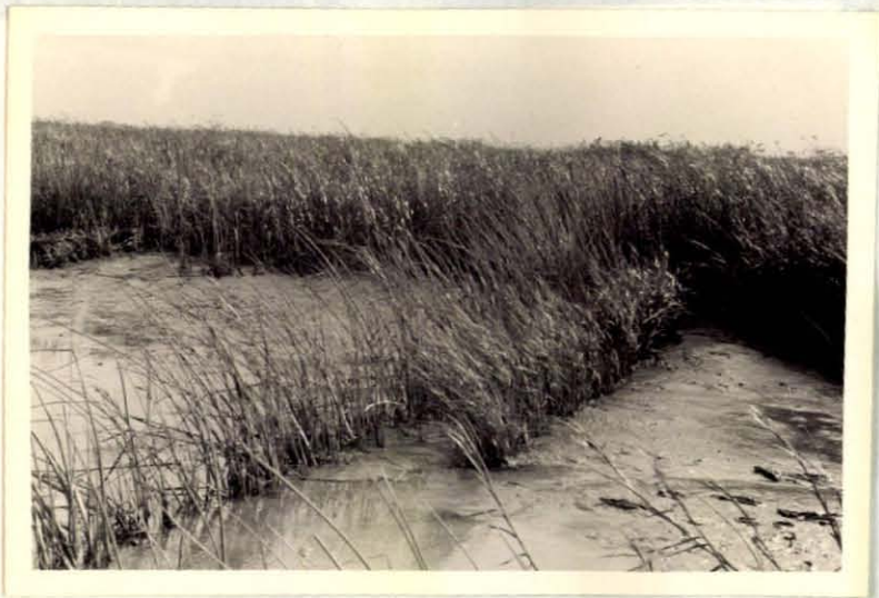
12. Rest van dammetje no. 11 na harden wind. Het riet is verdwenen, doch zegge en biezen zijn intact.
