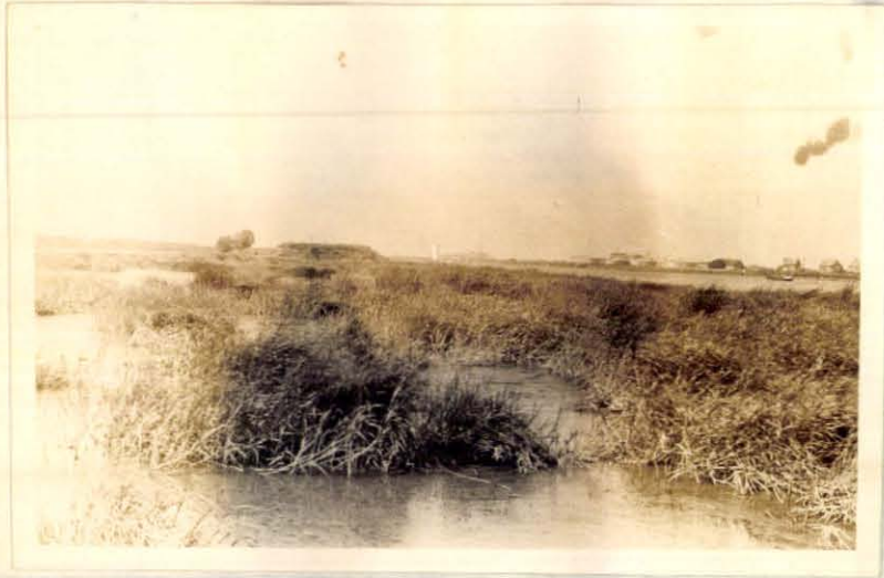
23. Natuurlijke opslag tusschen kribben aan de Oude Maas. De kribben werden in 1930 gemaakt in ruim 10 m water, zoodat de opslibbing ongeveer 1 m per jaar heeft bedragen.
