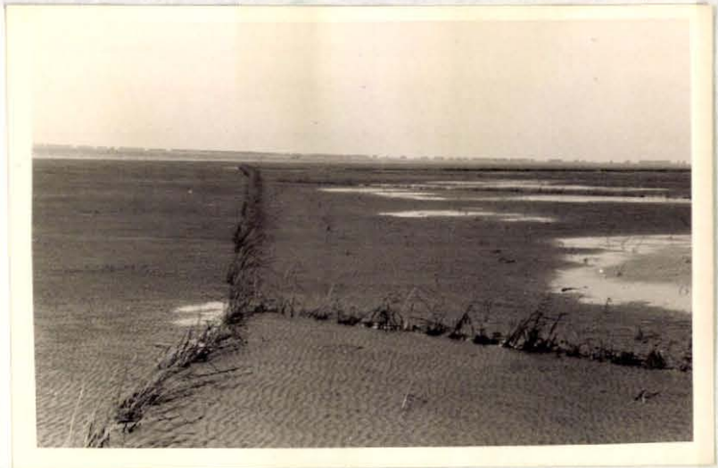
1. Hellegatplaat. Eenvoudigste scherm van levend materiaal, kort na het planten. Rechts van de schermen zijn biesstekken gepoot op 2 m onderlingen afstand.
