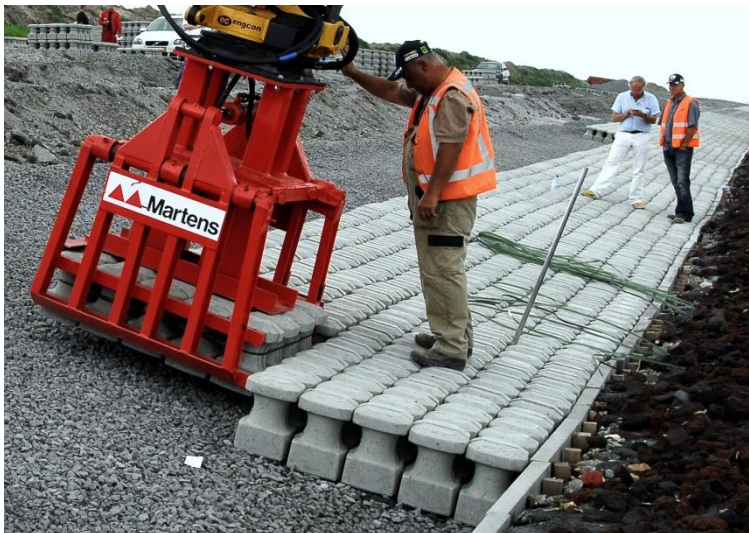
Figuur 4.1 Plaatsing van Hillblocks. Duidelijk zijn de open kanalen in de steenzetting te zien.
