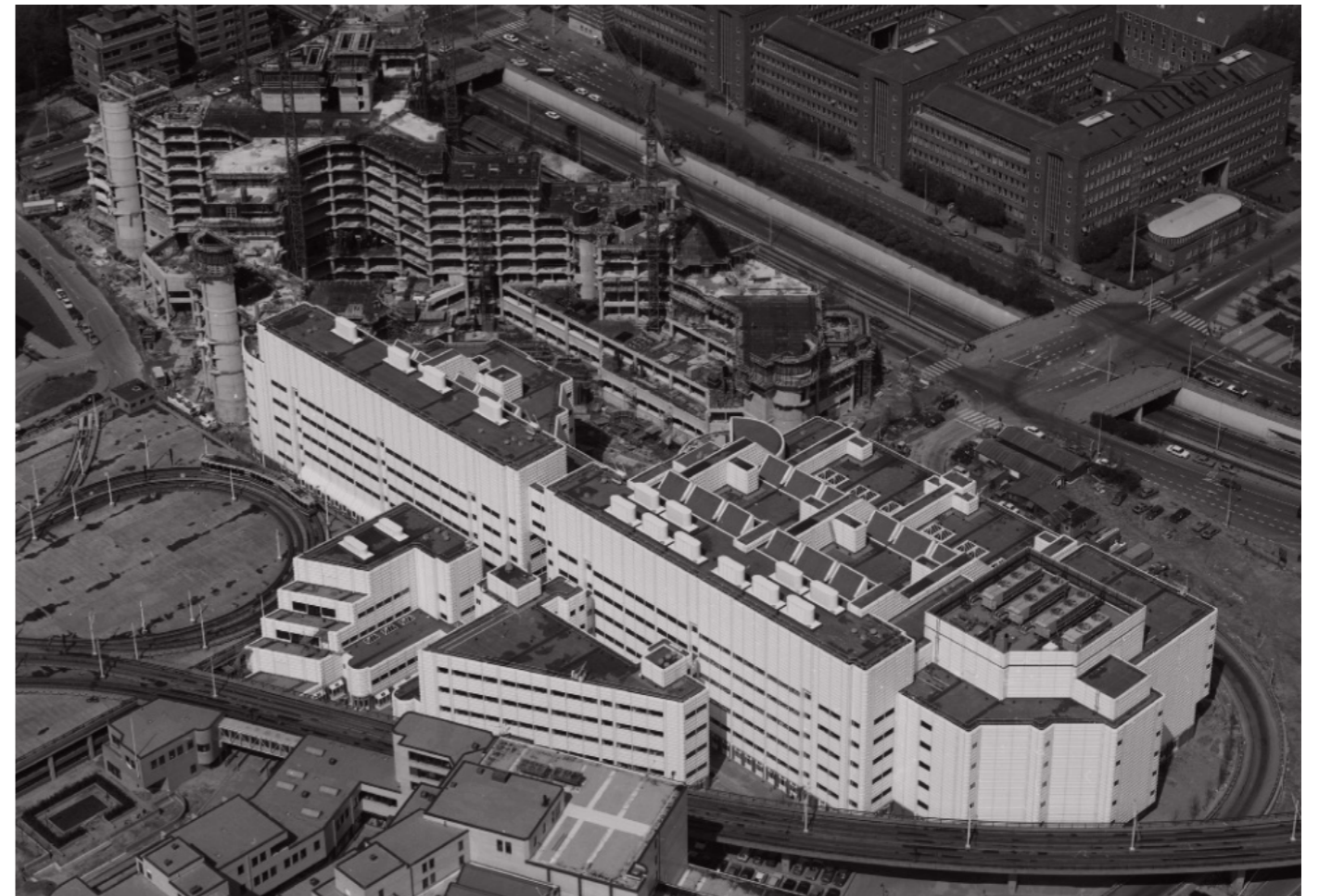
Image 1. Aerial view of the KB building (Gebouw Koninklijke Bibliotheek | 10-2020).
