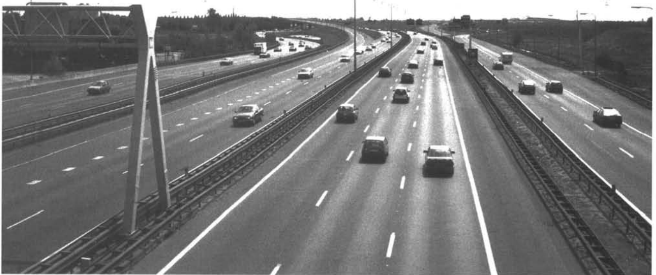
RING Rotterdam A16 ter hoogte van IJsselmonde, de toekomstige lay-out van de autosnelwegen in de Randstad: 2 x 2 + 2 x 3 rijstroken.
