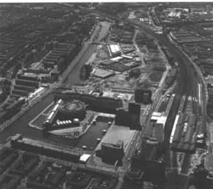
4.28 Laakhavengebied met Hogeschool, gezien vanuit het noordwesten, 1997. Foto Aeroview, D. Sellenraad.
