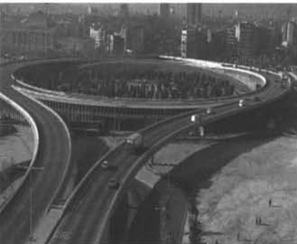
3.9 Barcelona, la placa de les Glories: voorbeeld van de integratie van infrastructuur in de stad. Uit: Nuria Casas / Lourdes Mateo, Barcelona, Art i espais urbans, Barcelona 1997.
