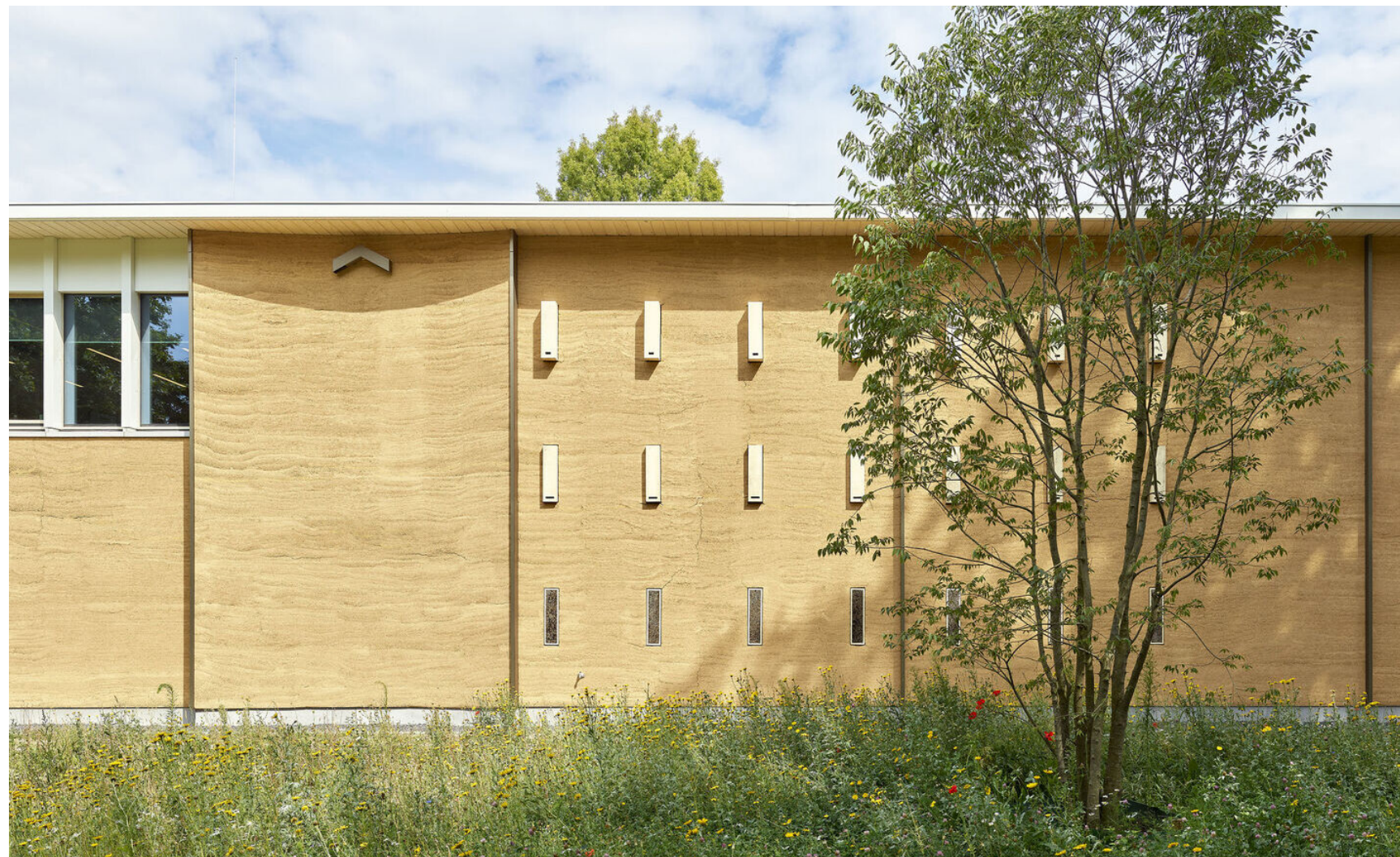
Project: De Twee Snoeken & EcoBouwSalland
