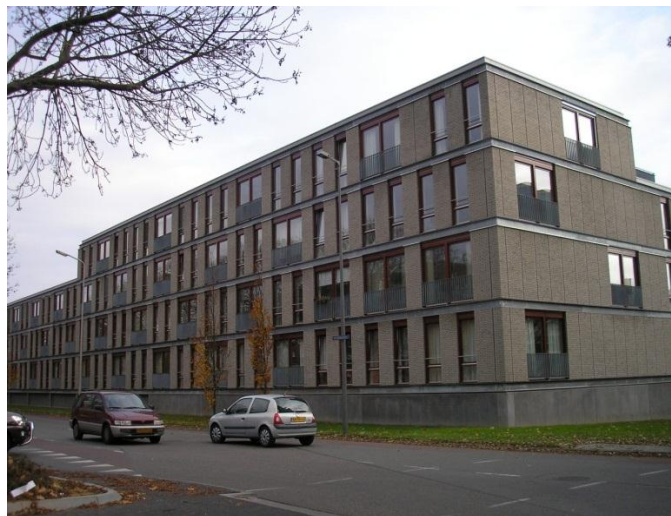
Figuur 8.7: Kernwaarde sjiek: de gevel van appartementencomplex Schellingruwe
