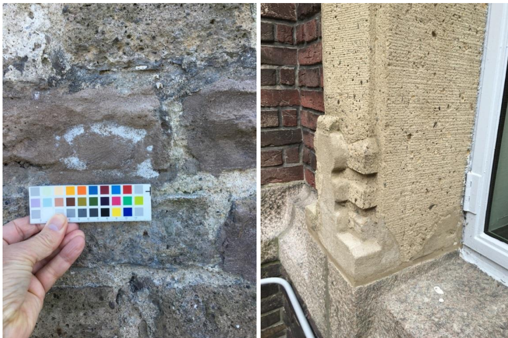
Fig. 6. Reparatie van tufsteen. Links: zowel qua kleur als textuur weinig geslaagde toepassing. Rechts: afwijkende textuur.
