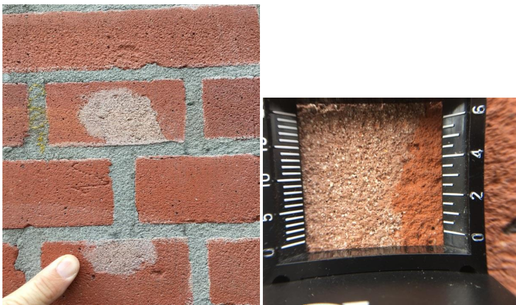
Fig. 3. Baksteenreparatie. Detail van de aansluiting.
