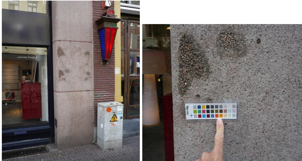
Fig. 5. Natuursteenreparatie: manifesteert zich op afstand als vlekken, van nabij als verschil in kleur en textuur ten opzichte van het oorspronkelijk materiaal (graniet).
