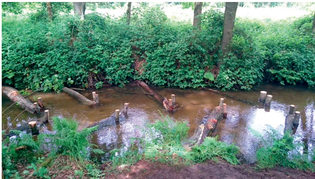
Afbeelding 3: Houtinbreng in Beekloop 't Schut
