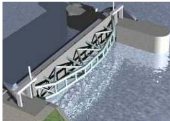
Figuur 7.1: Verticale hefschuif in de Eemskering. [www.ems-sperrwerk.de/grafiken]
