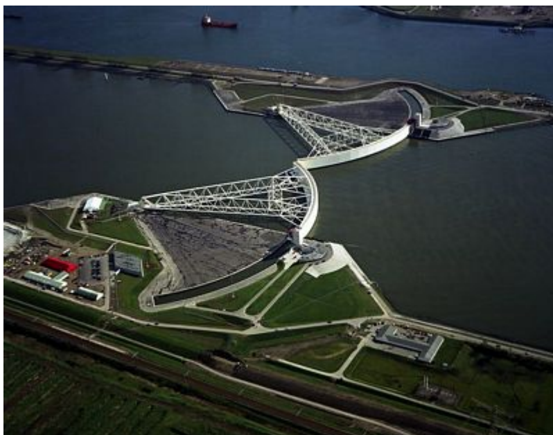
Figuur B2.6: De Maeslantkering sluit de Nieuwe Waterweg af, ook de parkeerdokken zijn goed te zien. [Rijkswaterstaat - Adviesdienst Geo-Informatie en ICT (AGI), www.deltawerken.com]
