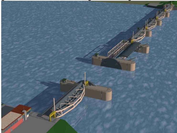
Figuur B2.14: Overzicht Eemskering bij Gandersum [www.ems-sperrwerk.de]
