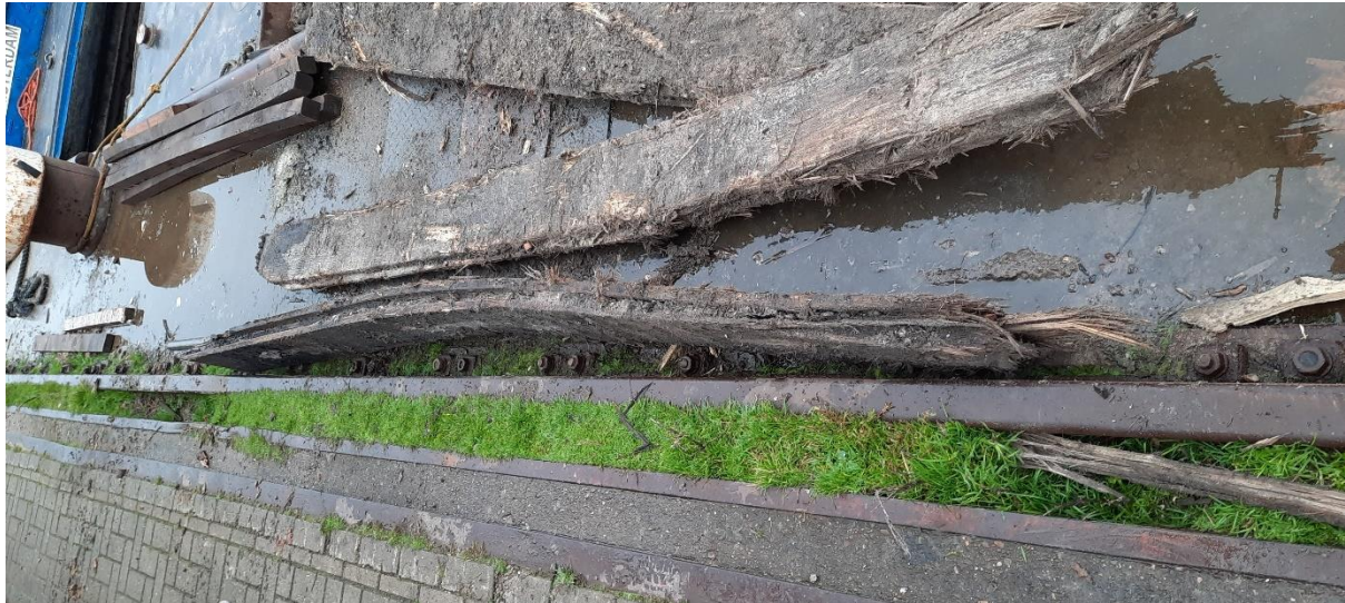
Figuur 4.6 Planken damwandscherm
