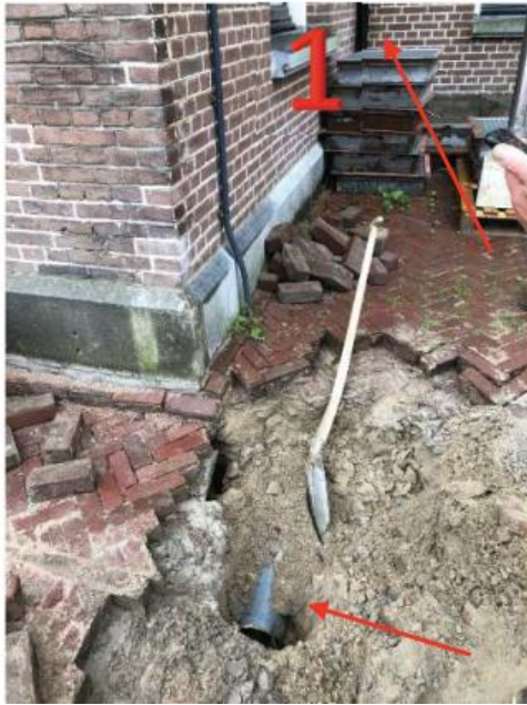
Figuur 3.3 Opengraven van de kade nabij de sinkholes en afgebroken HWA tussen 24 en 28 aug 2020 [6]
