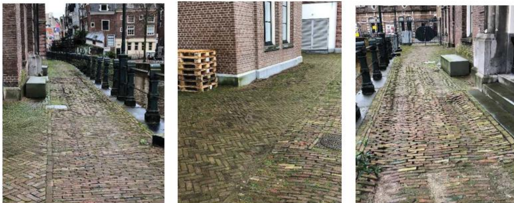
Figuur 3.1 Straatwerk in februari 2020 [6]
