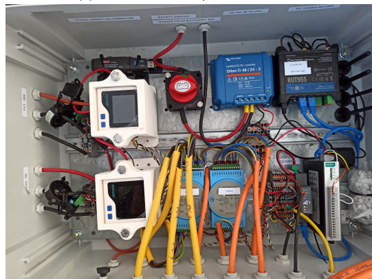
(d) Monitoring box components installed.
