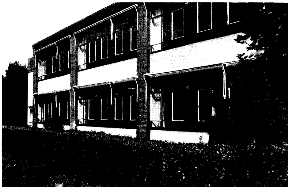
foto 3: Permanent lesgebouw uit 1953 met 12 lokalen.
