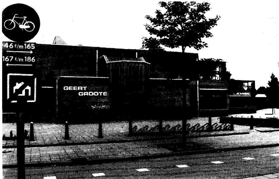
foto 10: Het zelfde complex van 3 lesgebouwen als afgebeeld op foto 9 vanuit een ander standpunt.
