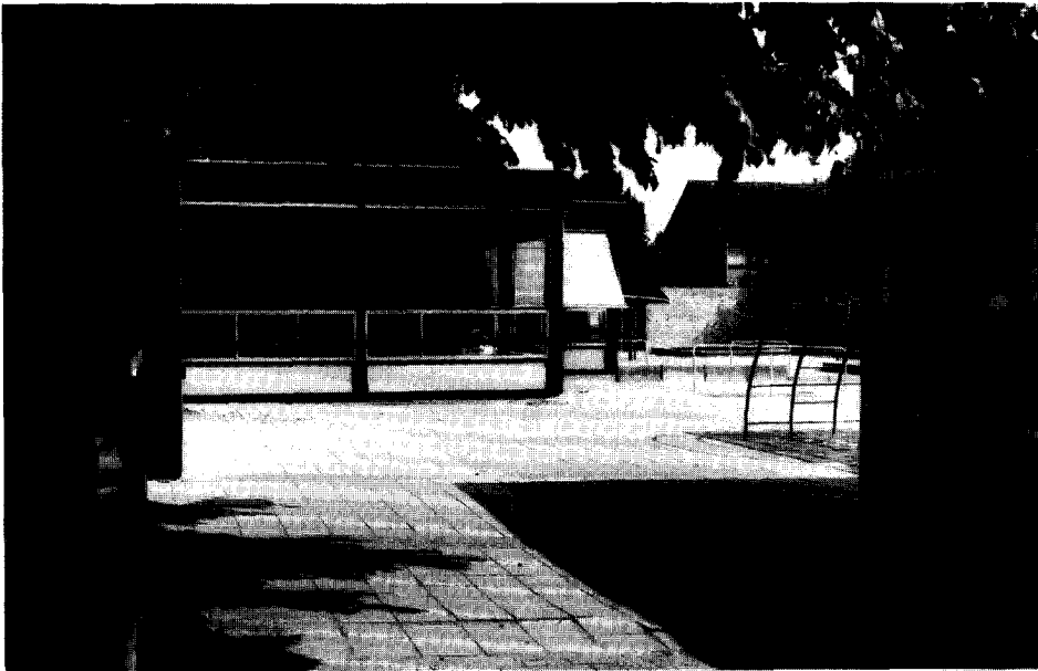
foto 1: Permanent lesgebouw uit 1975 met 8 lokalen, bij dit lesgebouw is in 1978, los van het permanente gebouw een noodschool met 3 lokalen geplaatst (links).
