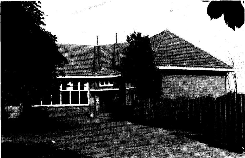
foto 2: Permanent lesgebouw uit 1923 met 2 lokalen.
