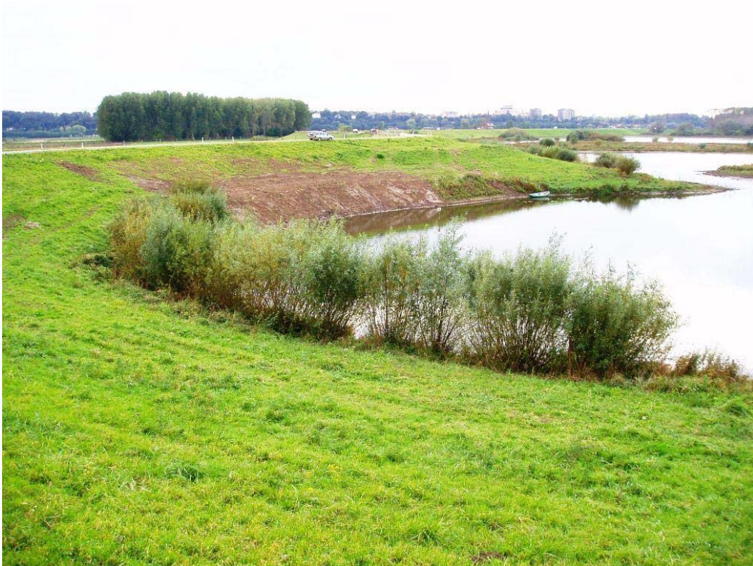
Figuur 5. Hersteld dijktalud na graverij door bevers. Ooyse Bandijk 2004.
