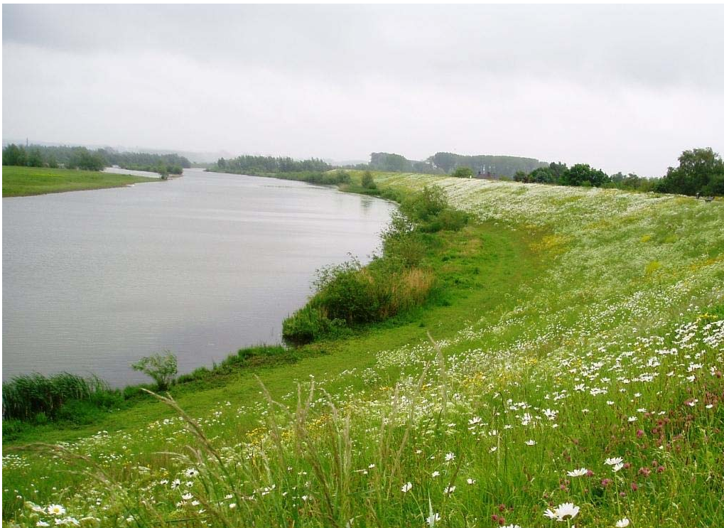
Figuur 9. Oude rivierstrang langs dijk in Bommel (Wz3). Kwetsbare locatie voor graverij in dijk door bevers.
