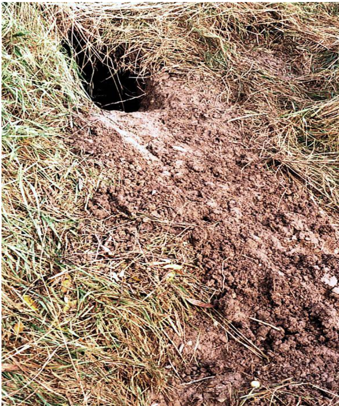
Figuur 2. Hol gegraven door bevers bij hoogwater boven in de rivierdijk bij Pannerden.
