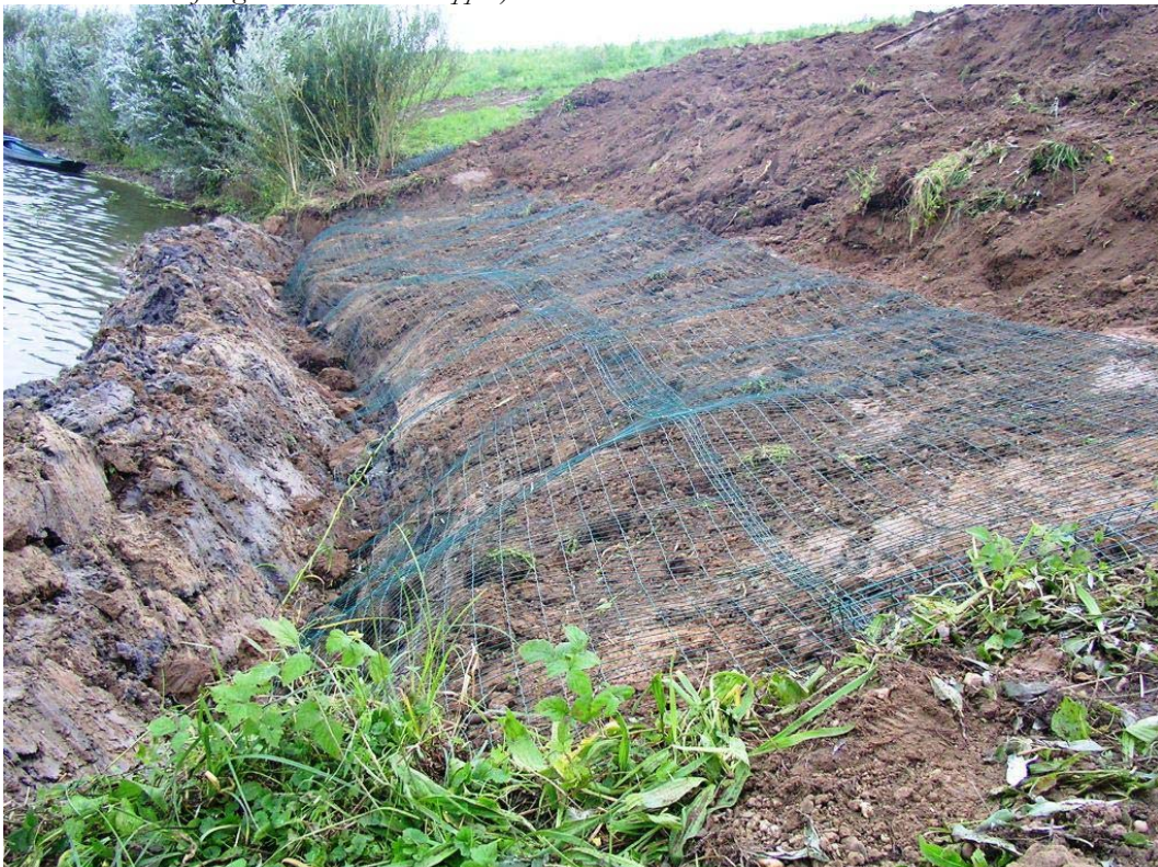
Figuur 4. Het aanbrengen van gaas in het talud van de Ooyse Bandijk na graverij door bevers in 2004 (Foto muskusrattenbestrijding Gelderse Waterschappen).
