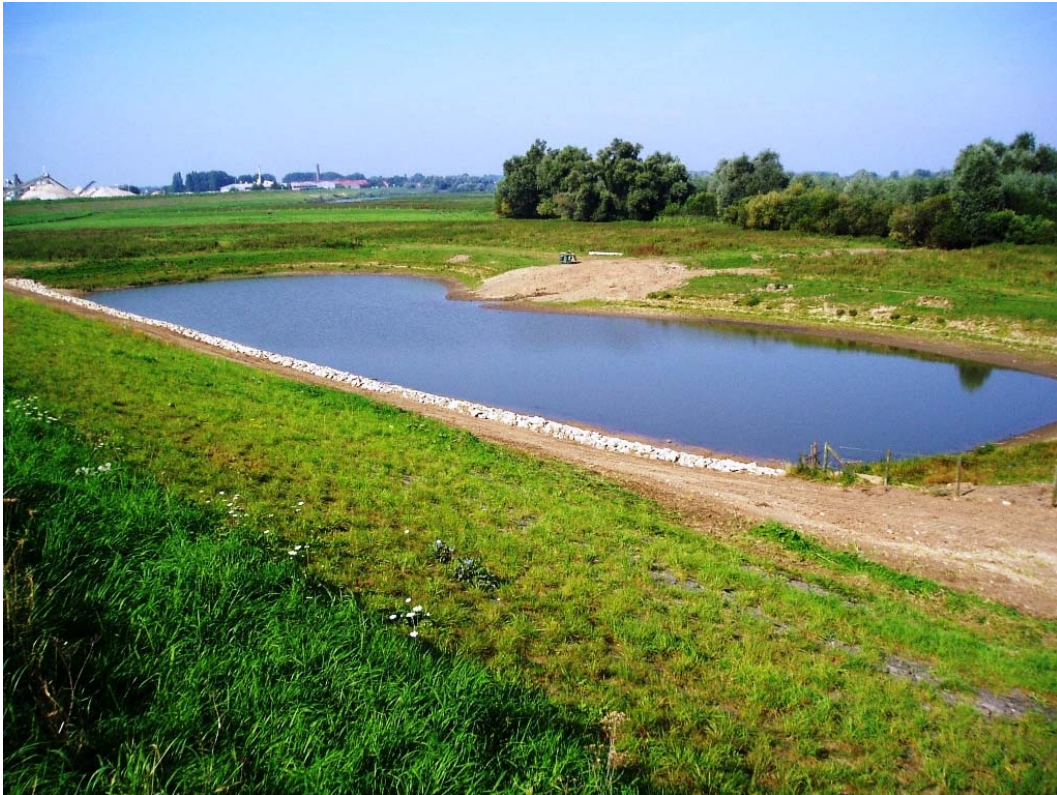
Figuur 6. Versterkte oever langs de Erlecomse Dijk (Wz11) na graverij door bevers.
