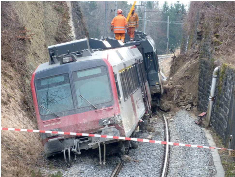
Figure 4.–Train qui a déraillé en février 2013, avec le mur qui a cédé et le dépôt des matériaux.
