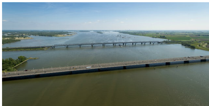
Figure 3.14: Moerdijkbrug at Hollands Diep (Rijkswaterstaat, n.d.-a)
