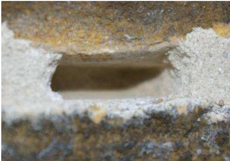
Figuur 3.9 Gedeeltelijk opengelegde voeg om de aansluiting tussen de voeg en de erachter liggende legmortel te controleren.
