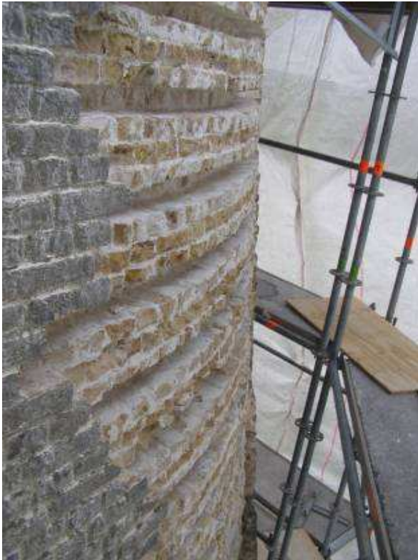
Fig. 1.6 Voorbeeld systeem C+ molenromp, uithakwerk
