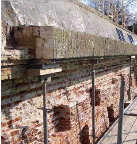
Fig. 1.8 Voorbeeld systeem E, uithakwerk (fortificatie)
