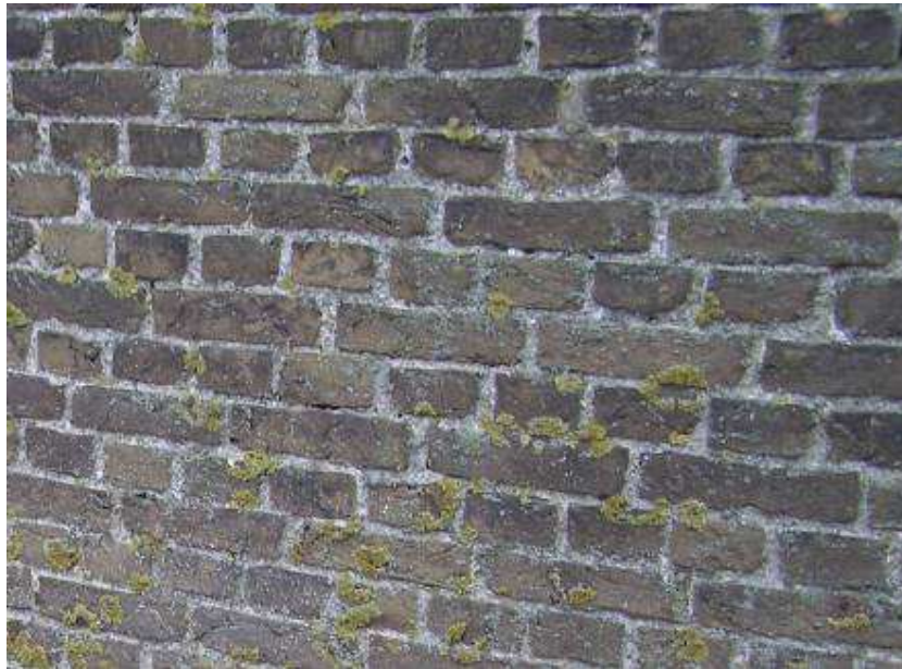
Figuur 3.2 Doorstrijkwerk is zeer duurzaam, het valt aan de noord en oostzijde van gebouwen soms nog in zijn oorspronkelijke toestand te zien (zoals op deze foto, doorstrijkwerk in kalkmortel (1767)), waarbij het soms zowel uit bouwkundig oogpunt als uit cultuurwaarden optiek beter is geen voegherstel uit te voeren.
