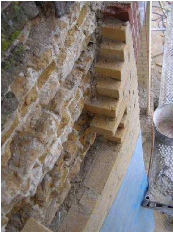
Fig. 1.6 Voorbeeld systeem C+ molenromp, uithakwerk
