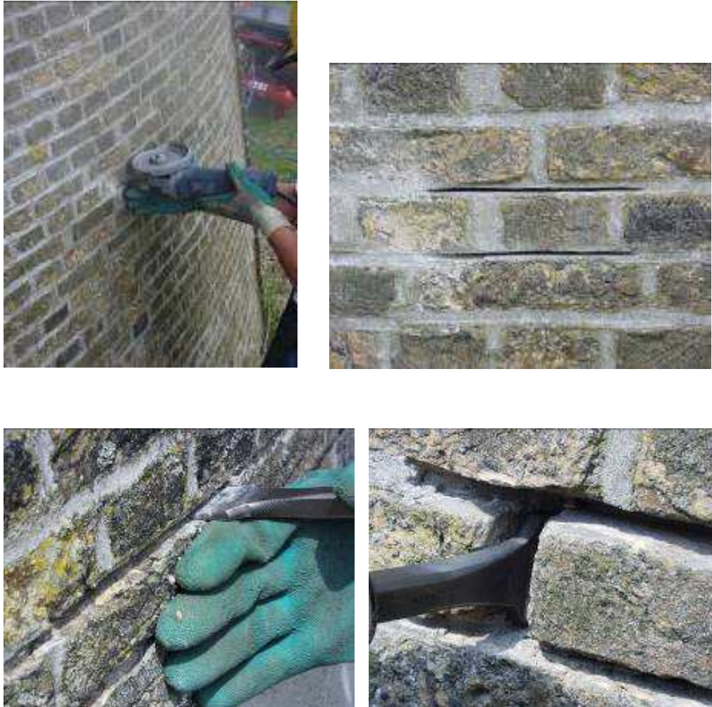
Figuur 3.7 Vakbekwaam uithakwerk
