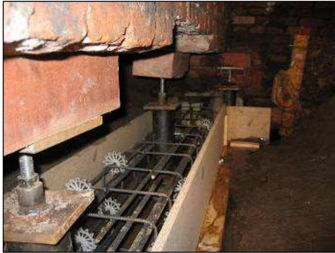
Figuur 2.4 Funderingsverbetering (bron www.allardvof.nl )
