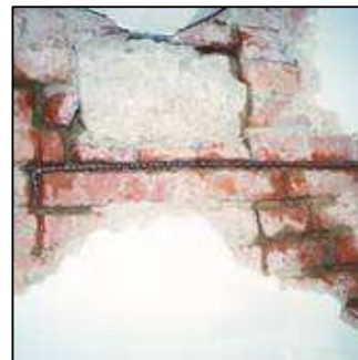
Figuur 2.5 Toepassing spiraalankers (bron: www.desoi.de )
