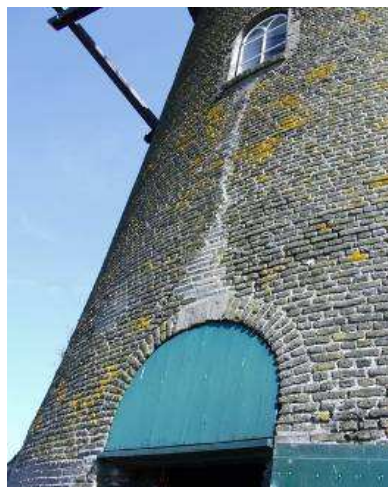
Figuur 2.8 Klassieke scheur in molenromp
