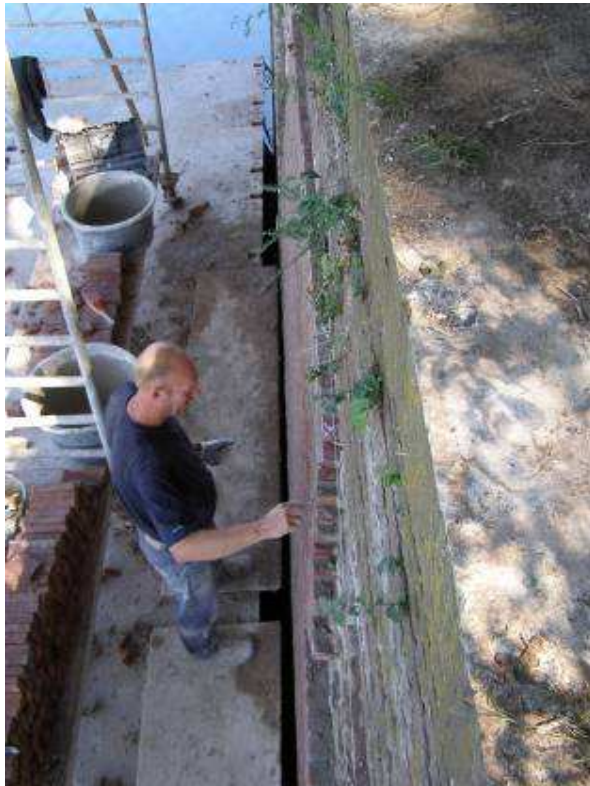
Fig. 1.5 Voorbeeld systeem C, vestingmuur; metselwerk in uitvoering
