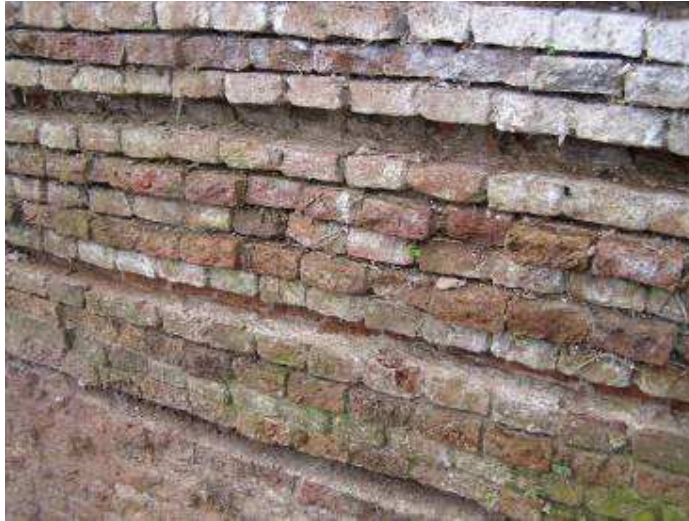
Fig. 1.4 Voorbeeld systeem C, vestingmuur; uithakwerk
