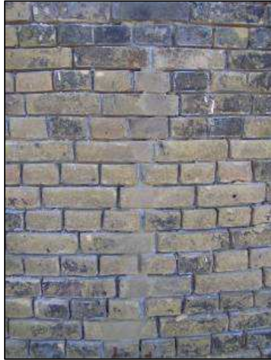
Figuur 2.6 Scheurherstel m.b.v. steenreparatiemortel
