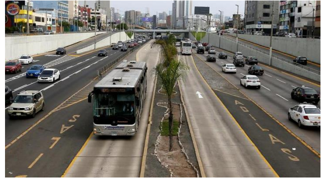
FIGURE 3.13: DE VÍA EXPRESA DE PASEO DE LA REPÚBLICA IN LIMA, PERU (CHIPANA, 2021).
