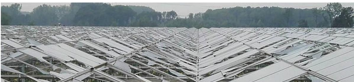
**Figure 3.1:** Impression of hail damage summer 2016 (retrieved from: [www.sierteltnet.nl](http://www.sierteltnet.nl), photographer: R. Kloppenburg)
