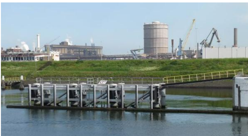
Figuur 24 – Stalen remmingwerk (noord-west van sluis)
