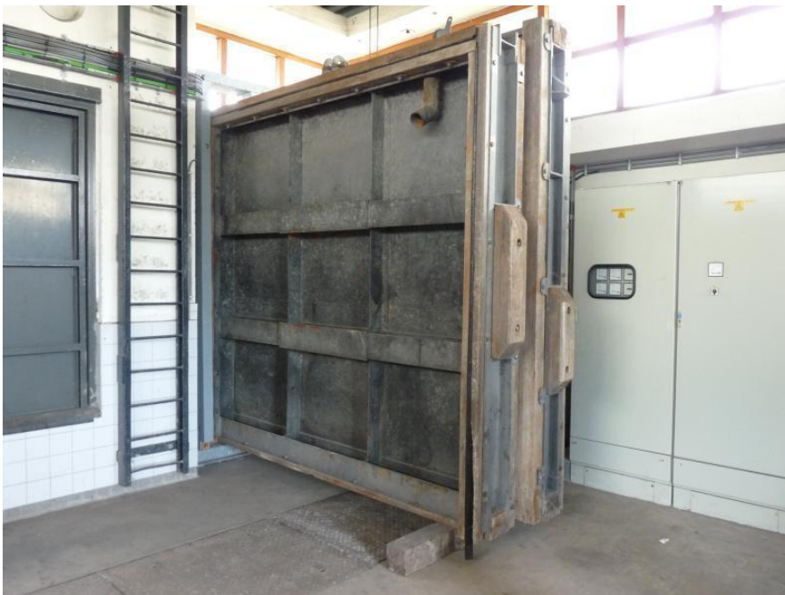
Figuur 19 – Onderhoudsschuiven
