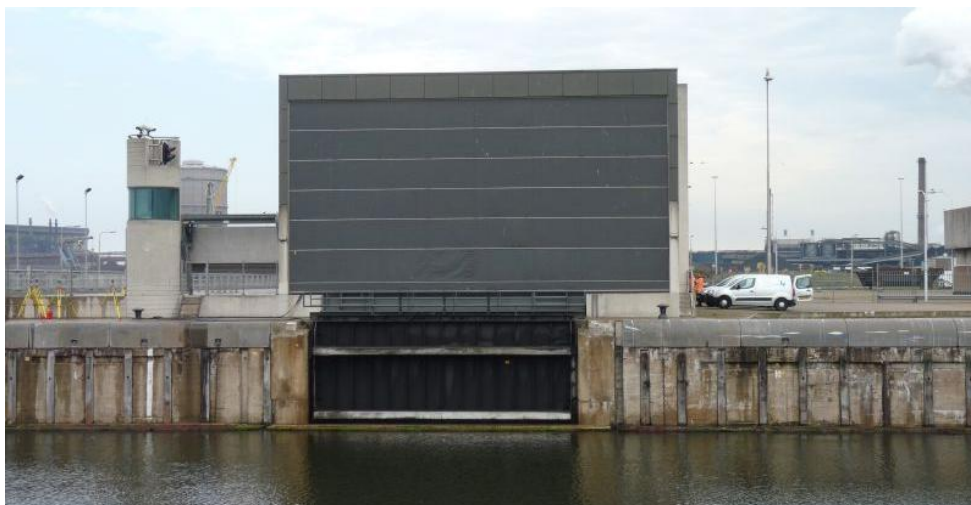
Figuur 16 – Schotbalken voor binnenste deurkas van buitenhoofd
