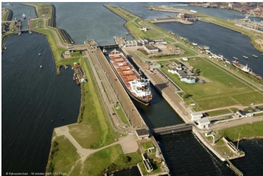
Figuur 2 – Overzicht sluiskolk Noordersluis
