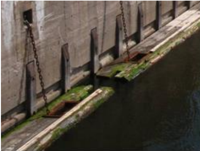
Figuur 25 – Geleidewerk aan westzijde (drijfrahmen)
