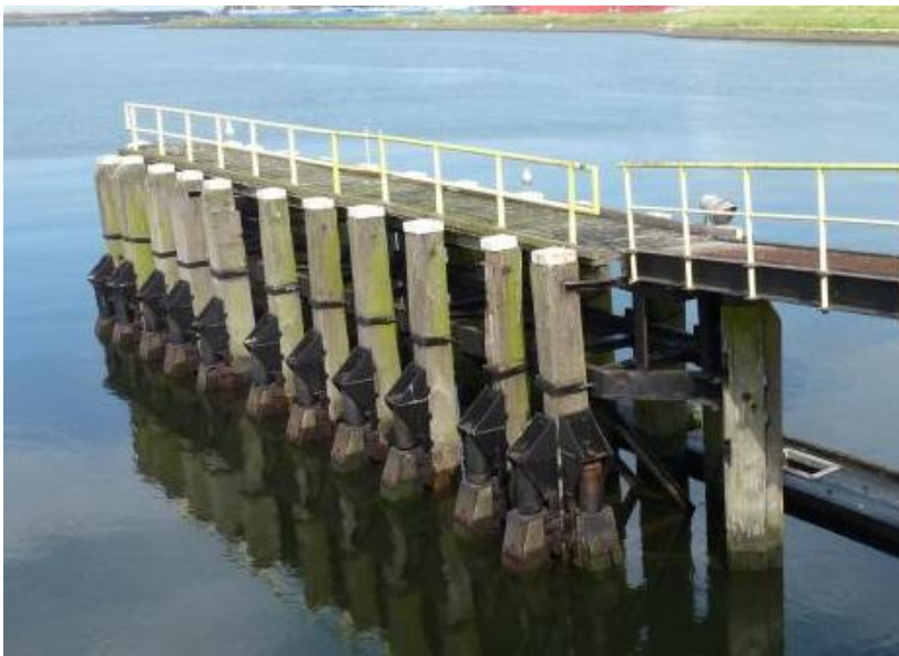
Figuur 23 – Houten remmingwerk
