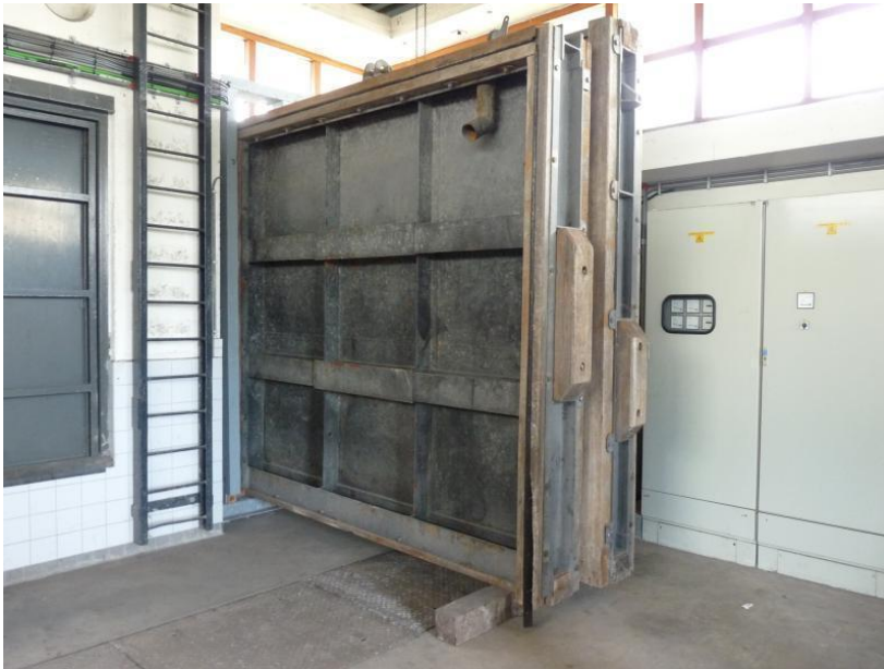
Figuur 8 - Onderhoudsschuiven
