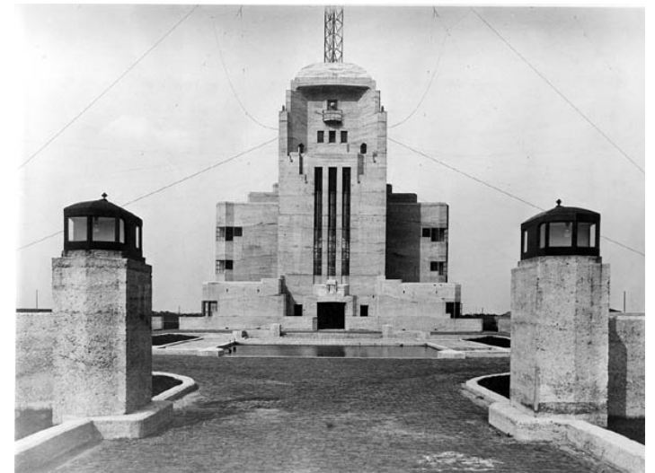
Het gebouw van Radio Kootwijk dat in 1918 speciaal voor de kostbare langegolfzender van Telefunken werd gebouwd was een ontwerp van de architect J. Luthmann. In 1922 werd de installatie in gebruik genomen. De eerste verbinding met Java werd op 18 januari 1923 tot stand gebracht. collectie museum voor communicatie, den haag
