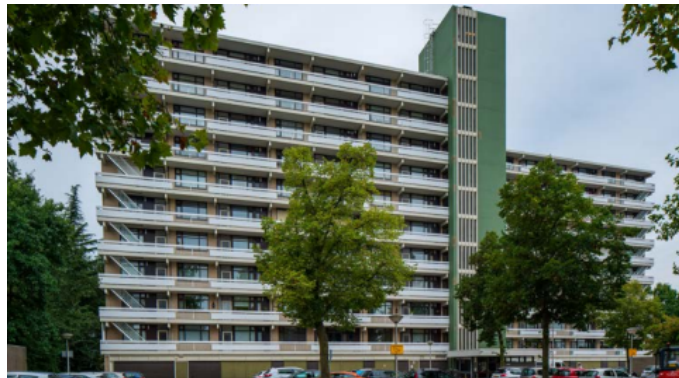
Figure 21: Example of a Gallery building (Rijksdienst voor Ondernemend Nederland, 2022).
