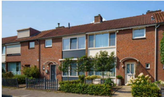
Figure 27: Example of a terraced house (Rijksdienst voor Ondernemend Nederland, 2022).
